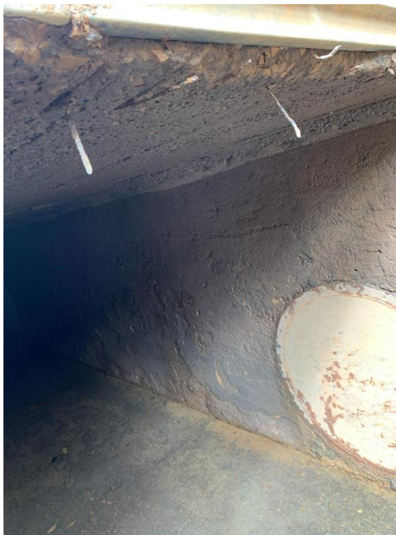
Figura 6 – Teto do duto do canal de adução forçada
