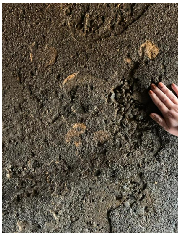
Figura 7 – Parede do duto do canal de adução forçada
