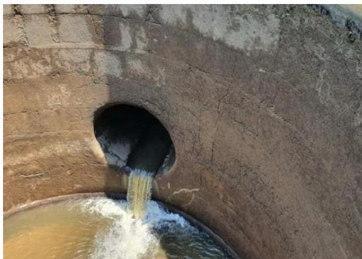
Figura 2 – Chaminé de Equilíbrio (Lado interno)
