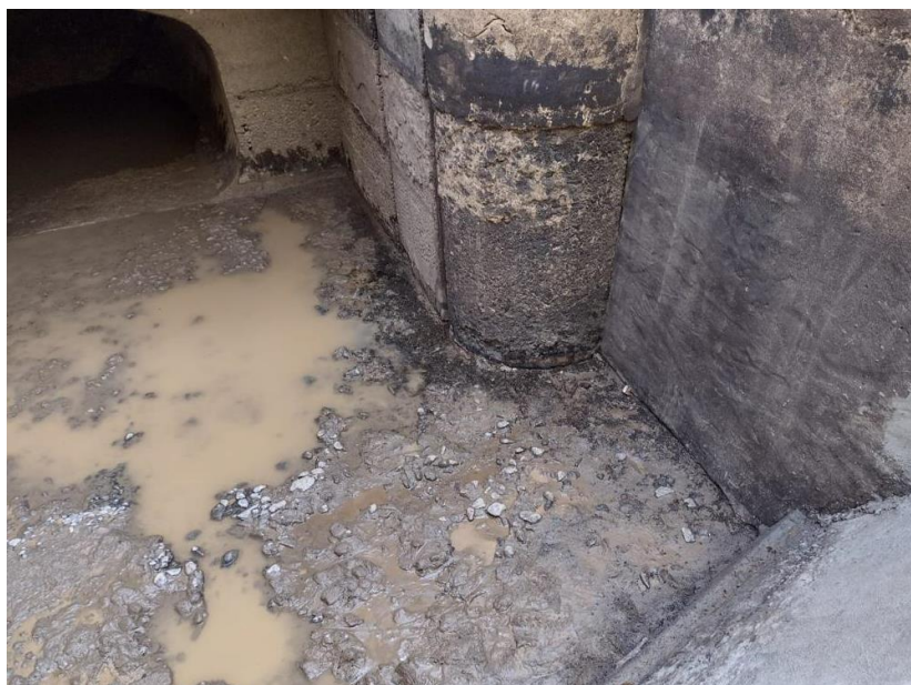
Figura 5 – Canal de Fuga
