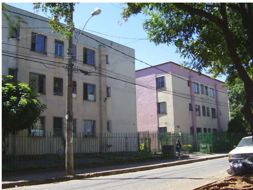
Figura 5.4 – Vista externa da edificação situada a Rua Itamar Teixeira em Belo Horizonte/MG.
