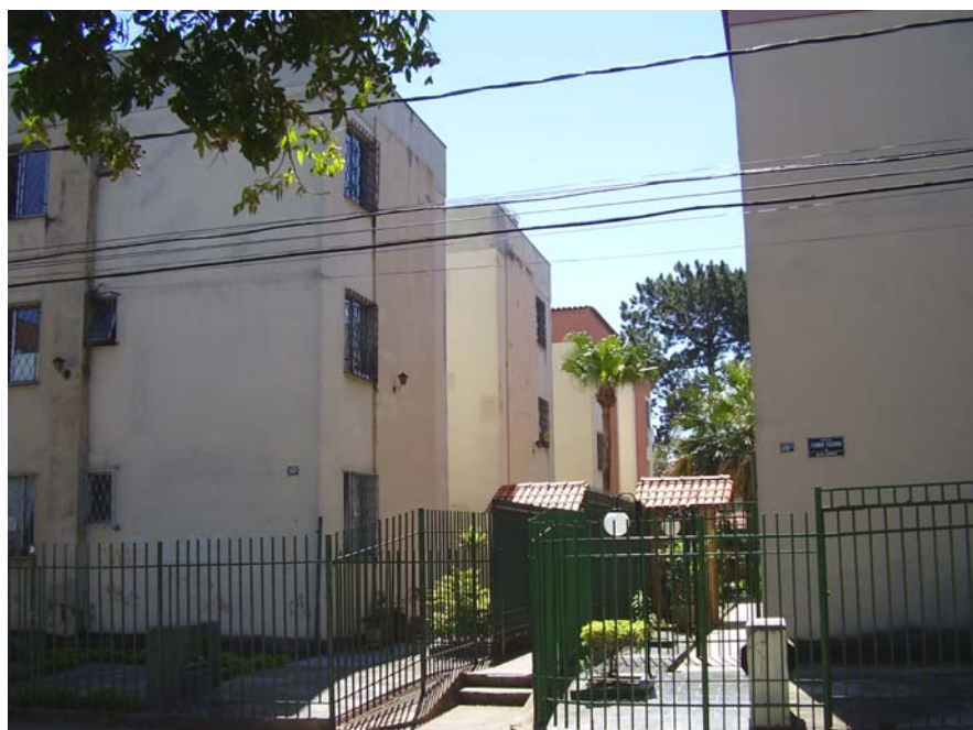
Figura 5.6 – Vista externa da edificação situada a Rua Itamar Teixeira em Belo Horizonte/MG.
