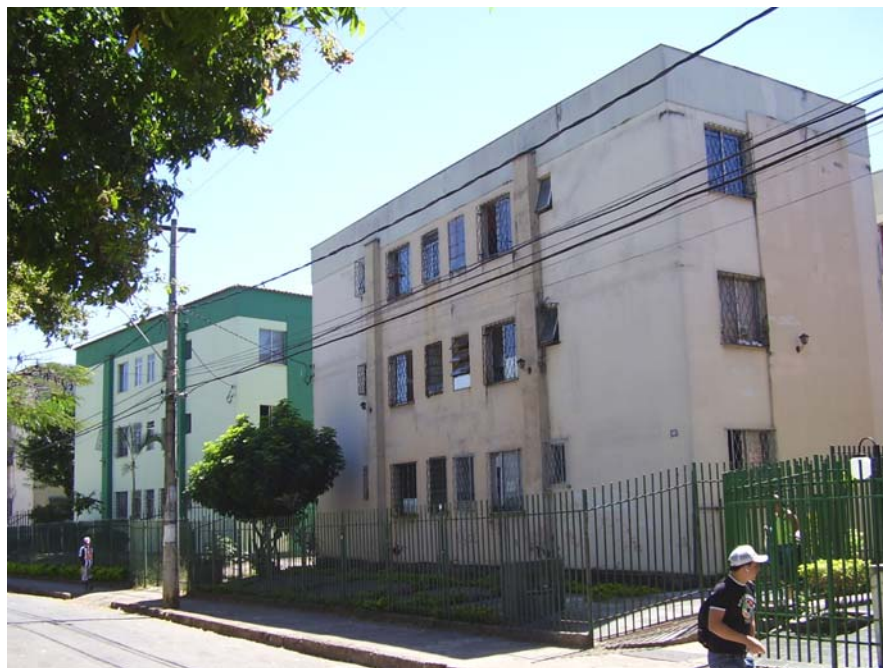
Figura 5.5 – Vista externa da edificação situada a Rua Itamar Teixeira em Belo Horizonte/MG.
