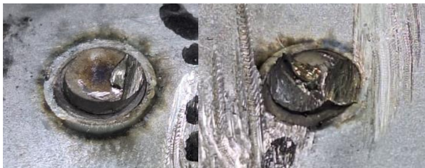
Figura 6 – Teste de destaque comprometido pelo marteleto (Fonte: autor)
