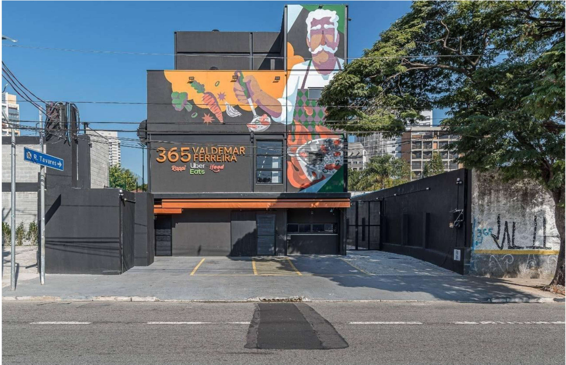
Figura 9 - Fachada de uma Dark kitchen da empresa Kitchen Central, no bairro Butantã em São Paulo (SP)
