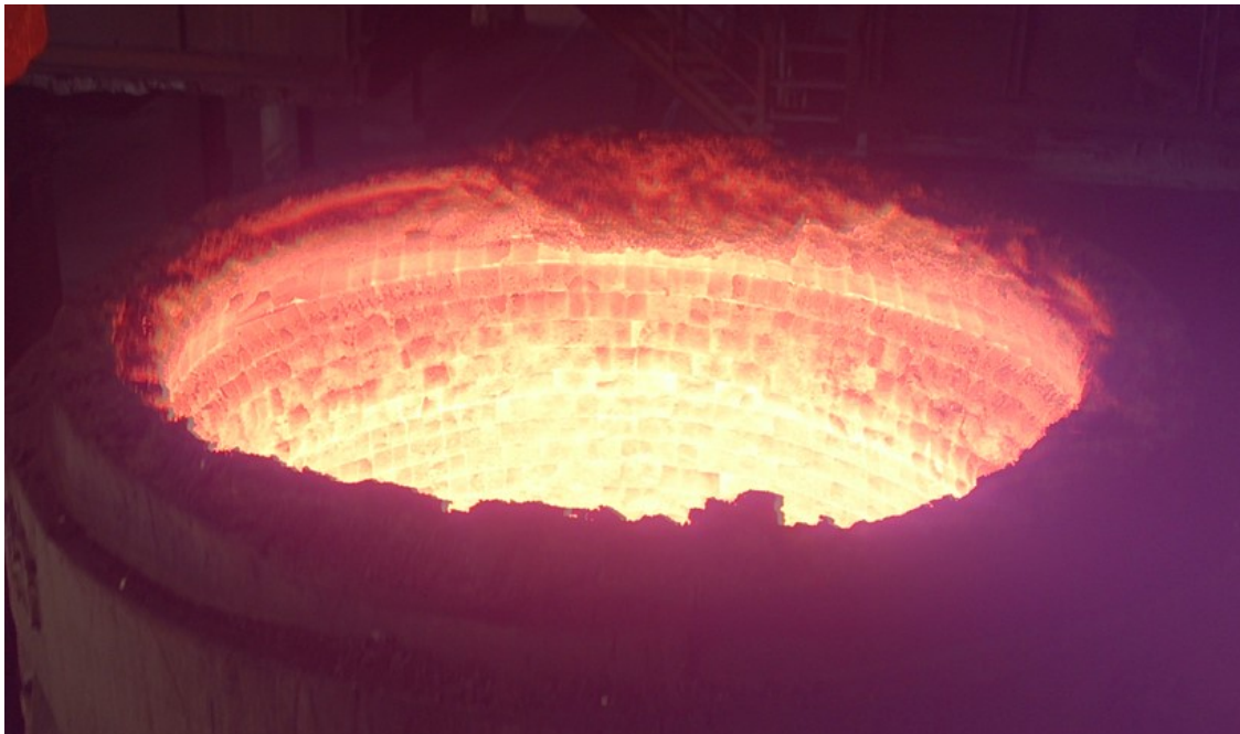
Figura 1 – Desgaste corrosivo observado na região de linha de escória de uma panela de aço.
