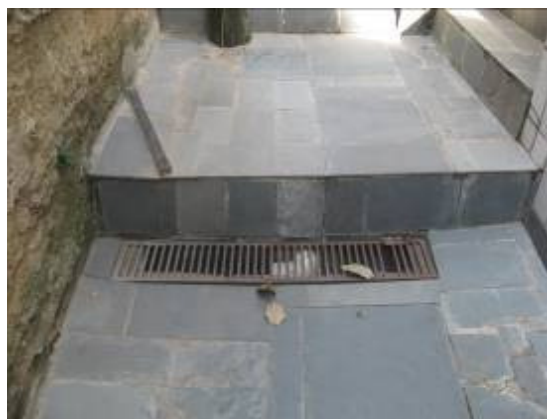
FIGURA 19: Vista do beco no “lado de baixo” próximo à Rua Miguel Abras. Destaque para a pavimentação com pedra ardósia realizada pelos moradores, para o revestimento cerâmico das casas e para o sistema de drenagem das águas pluviais. Foto da autora.
