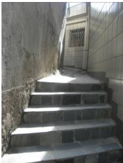
FIGURA 19: Vista do beco no “lado de baixo” próximo à Rua Miguel Abras. Destaque para a pavimentação com pedra ardósia realizada pelos moradores, para o revestimento cerâmico das casas e para o sistema de drenagem das águas pluviais. Foto da autora.
