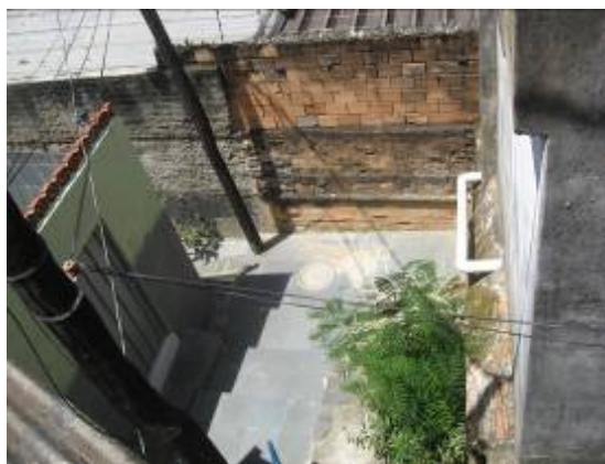
FIGURA 20: Detalhe para a qualidade da iluminação e ventilação naturais existentes em um trecho do beco do “lado de baixo”. Foto da autora.
