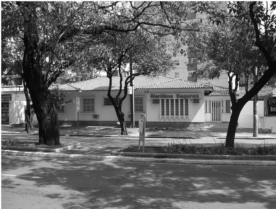
FIGURA 44 – Antiga res. José Maria Alkmim. Fachada da av. do Contorno. Foto do autor, 2007.
