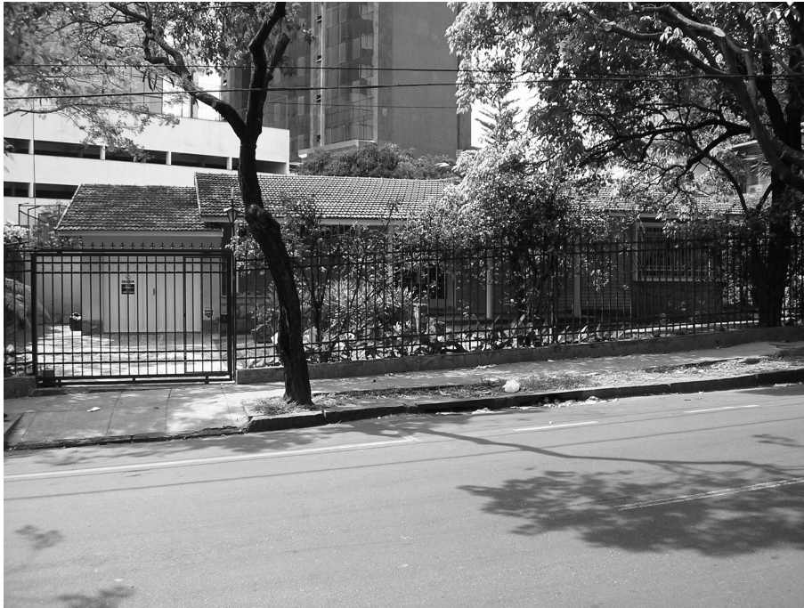
FIGURA 35 – Antiga res. à rua Bernardo Mascarenhas. Lote 10. Fachada frontal. Fonte: Foto do autor, 2007.
