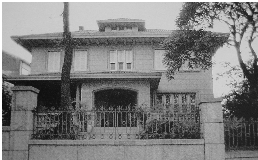
FIGURA 25 – Antiga res. Antônio Mourão Guimarães. Fachada frontal. Fonte: BERTI, 2000, p. 94.
