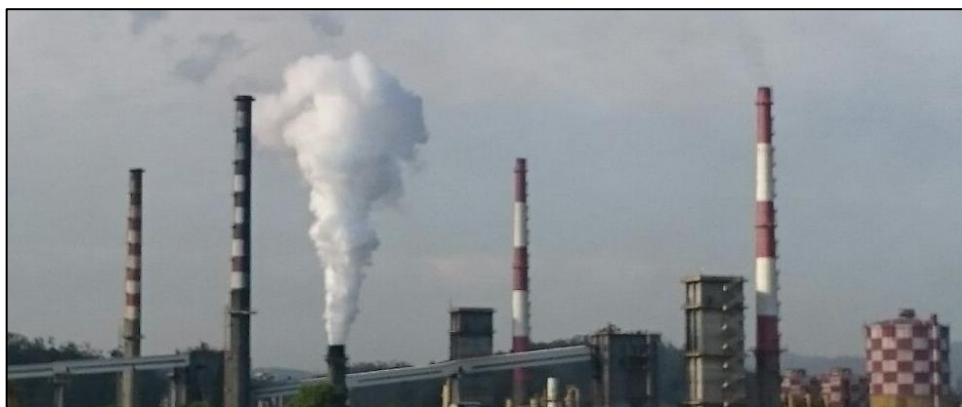
FIGURA 2.4 – Vapor de água produzido após o resfriamento do coque na coqueria da Usiminas Ipatinga FONTE - Autor
