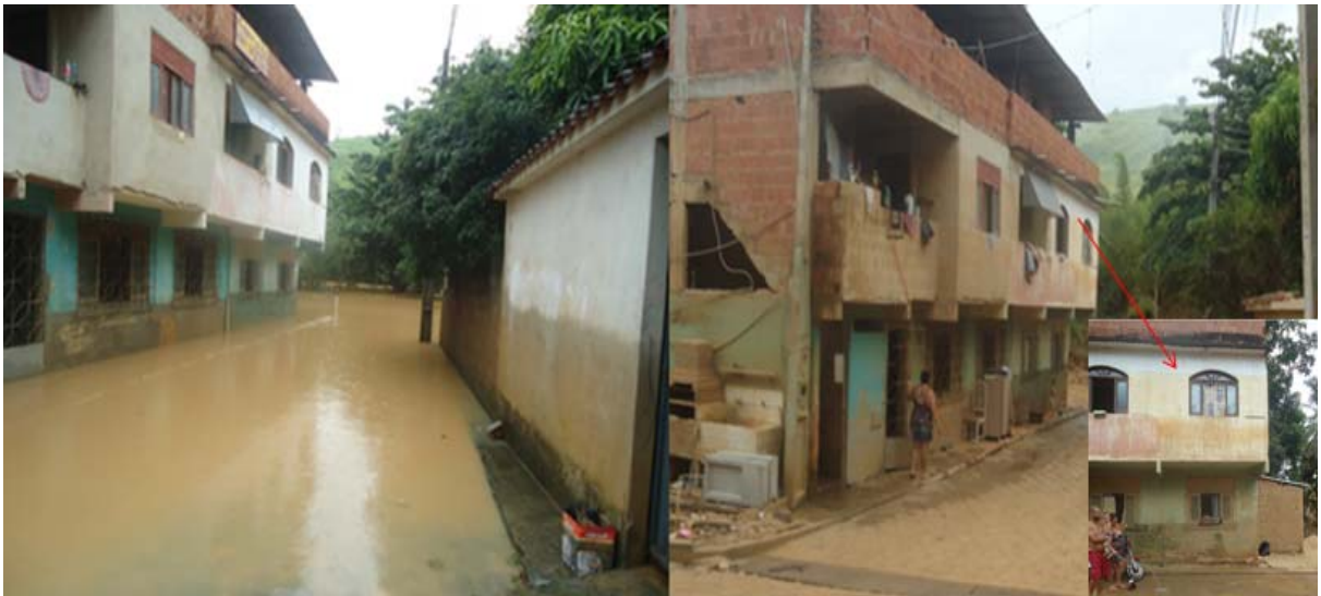
Figura 4.9 - Situação das residências localizadas às margens do rio Santa Maria após a cheia do dia 19-12-2013 e após a cheia do dia 24-12-2013, respectivamente Fonte: arquivos do autor.
