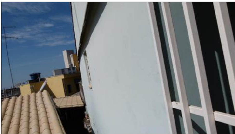
Figura 5: Foto de residência em Belo Horizonte, em 21/07/2013
