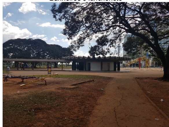
Figura 30 – Estrutura central Parque Ana Lúcia – Banheiros e lanchonete
