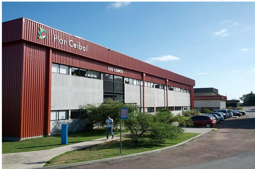
Fotografia 2 – Edifício Los Ceibos em Montevidéu/Uruguay
