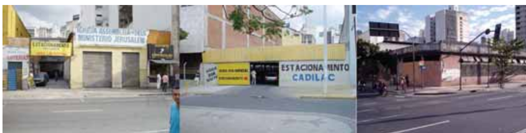
Figura 17 – Galpões sem indicação para preservação – Rua Guaicurus, Av. Oiapoque e Av. Contorno
