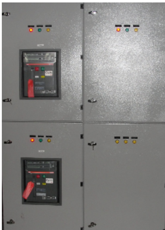
Figura 5.4 - Retificador e transformador para alimentação das pontes rolantes
