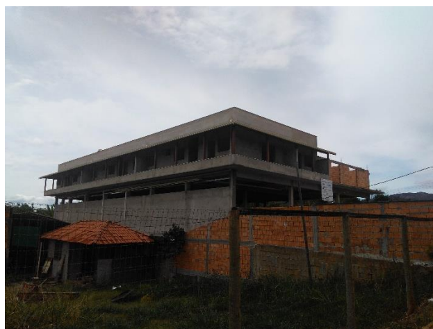
Figuras 43, 44, 45, 46 e 47: Quitinetes no segundo pavimento, localizadas na área central do distrito, destinadas para aluguel residencial. Fonte: Arquivo da autora – junho/2018
