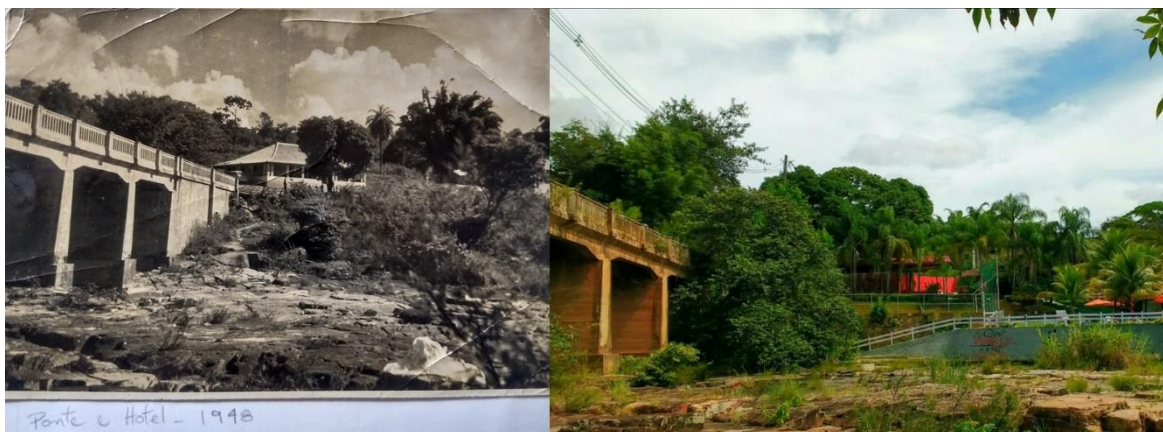
Figuras 06 e 07: Ponte sobre o rio Cipó e Hotel Veraneio 1948 (esquerda) e 2019 (direita). Fonte: imagem 1948 (arquivos da família proprietária do Hotel Veraneio 47 ); imagem 2019 (arquivos da autora)
