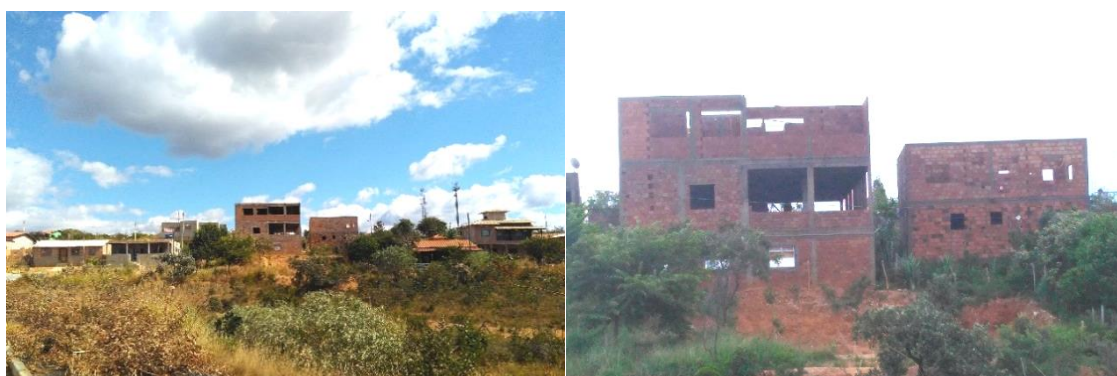
Figuras 33 e 34: Novas construções no bairro Progresso. Foto: arquivo da autora julho/2018
