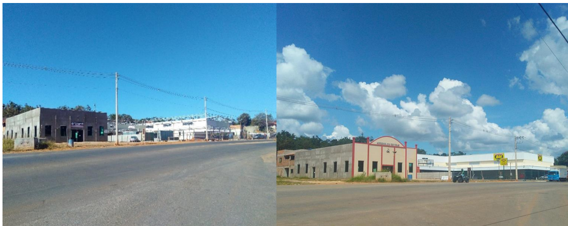
Figura 32: Nova Igreja Evangélica e novo supermercado da rede BH Supermercados. Foto: arquivo da autora - Imagem esquerda: julho/2018 e Imagem direita: abril/2019
