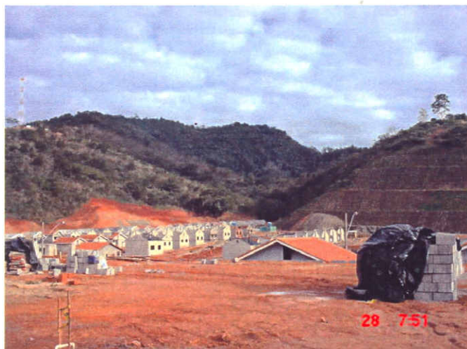
Figura 32: Construção da cidade de Nova Itueta em Minas Gerais, 2004.
