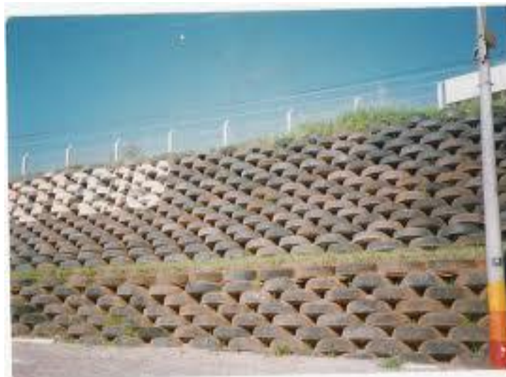
Figura 9: Muro de pneus
