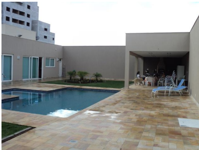
Figura 58: Área Externa da residência
