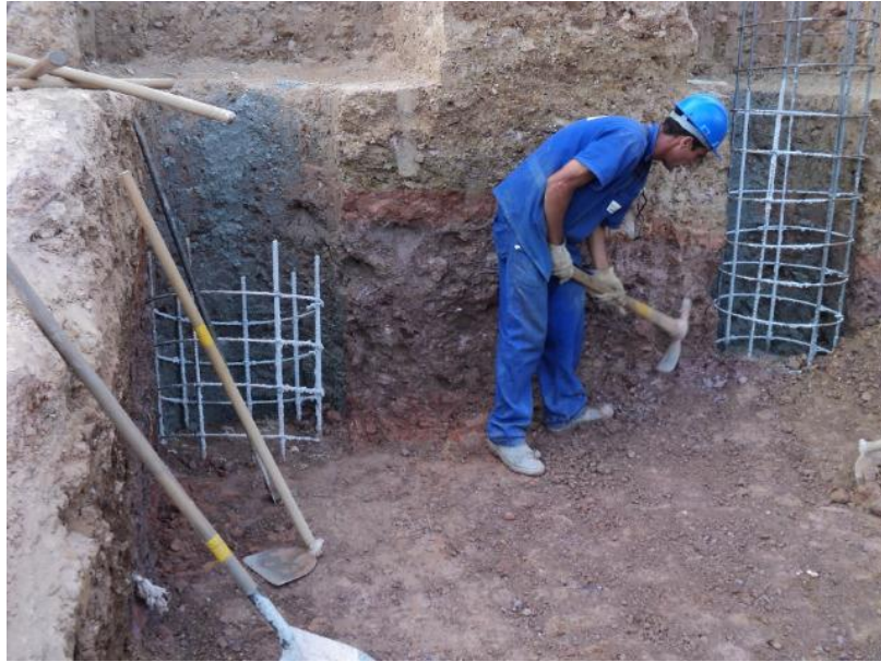
Figura 50: Tubulões concretados Fonte:O autor (2010)
