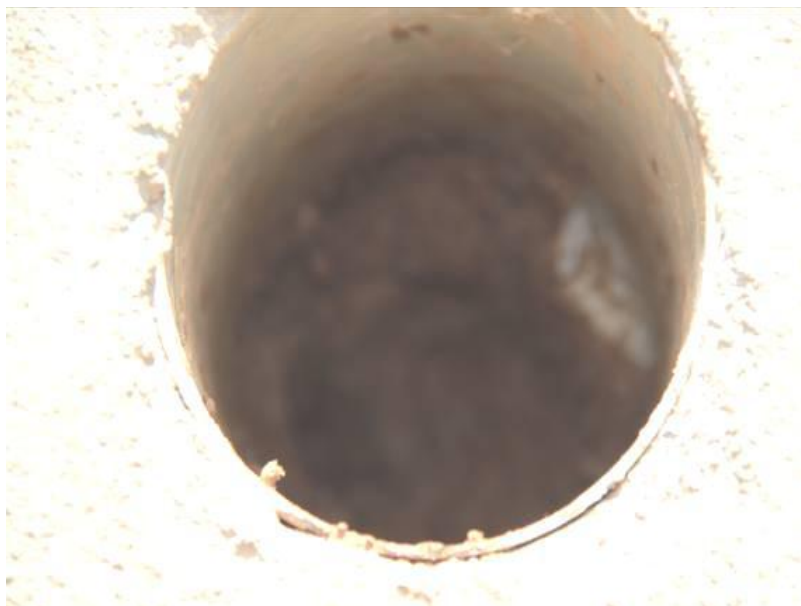
Figura 41: Detalhe do barbacã Fonte: Parecer técnico – SARDINHA (2010)
