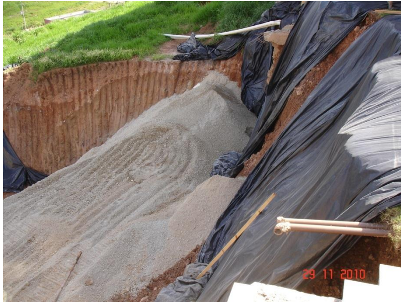
Figura 33: Berma para proteção do talude Fonte:O autor (2010)
