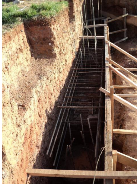
Figura 52: Armação do cinto para travamento dos tubulões Fonte:O autor (2010)
