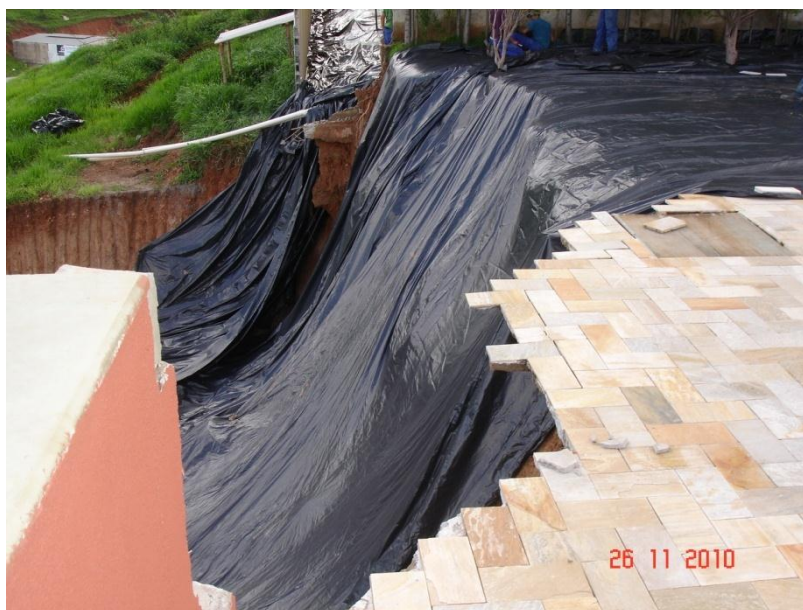
Figura 31: Proteção da área permeável e talude. Fonte:O autor (2010)
