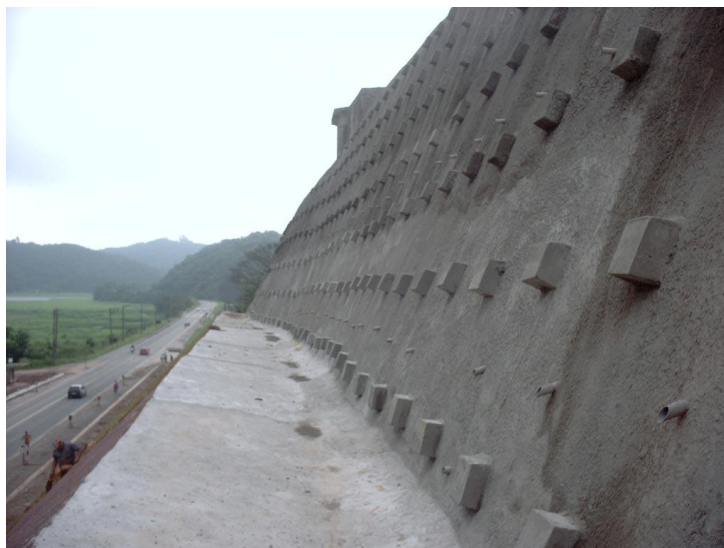
Figura 10: Cortina atirantada Fonte: http://www.solofort.com/cortina.html
