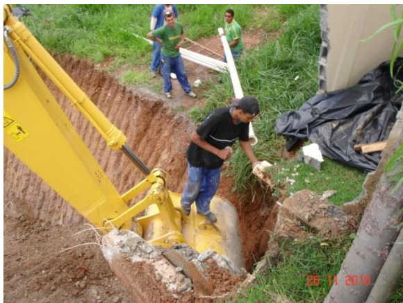
Figura 30: Execução do desvio da água pluvial Fonte: O autor (2010)
