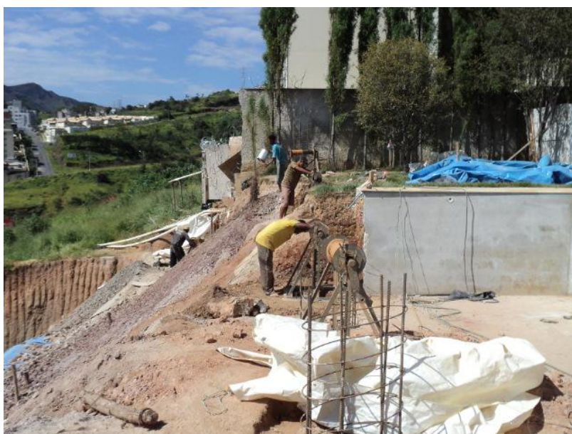
Figura 49: Escavação de tubulões para base do muro de arrimo Fonte:O autor (2010)
