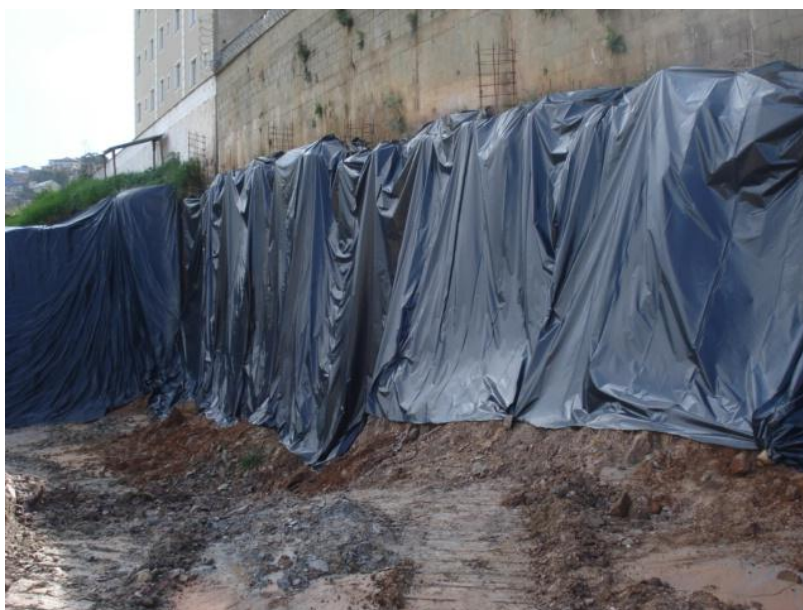
Figura 20: Escavação finalizada e proteção da contenção Fonte:O autor (2010)
