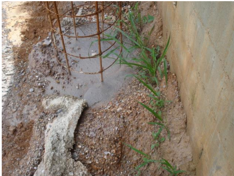
Figura 19: Tubulões concretados. Fonte:O autor (2010)
