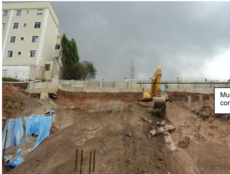
Figura 53: Muro de arrimo finalizado Fonte:O autor (2010)
