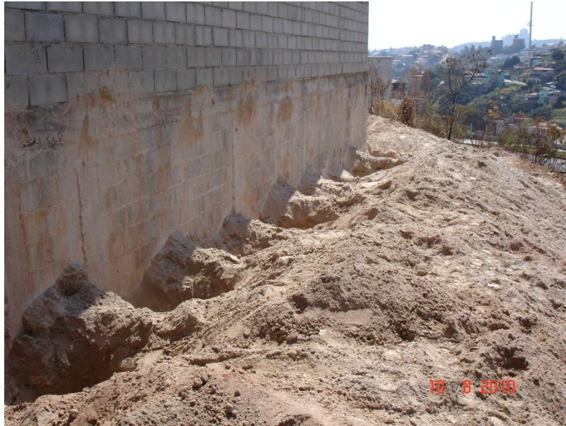
Figura 18: Tubulões escavados. Fonte:O autor (2010)
