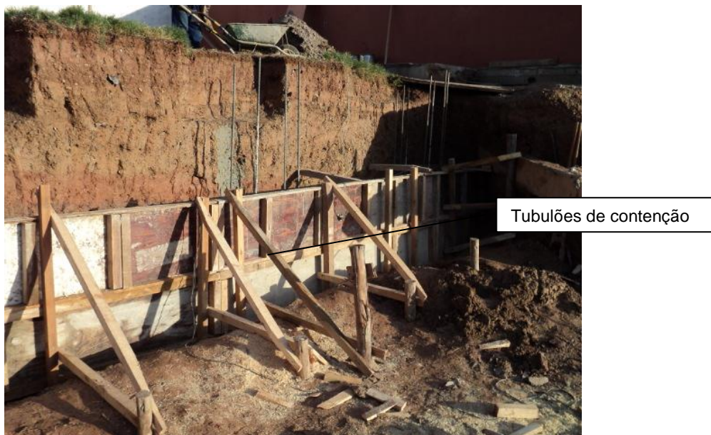
Figura 51: Cintamento para travamento dos tubulões Fonte:O autor (2010)
