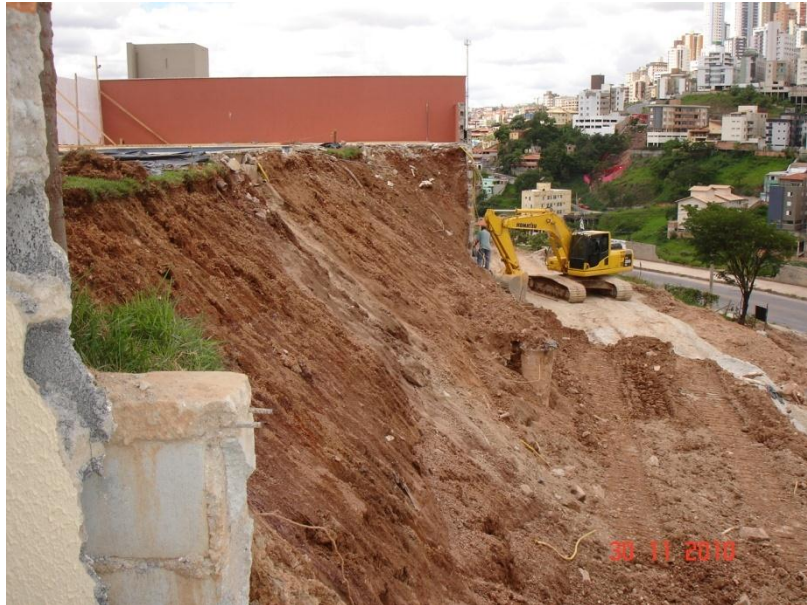
Figura 35: Correção da inclinação do talude Fonte:O autor (2010)
