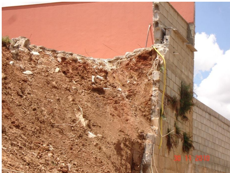
Figura 34: Demolição restante do muro Fonte:O autor (2010)
