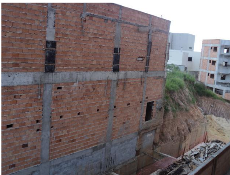
Figura 55: Muro de divisa finalizado Fonte:O autor (2010)
