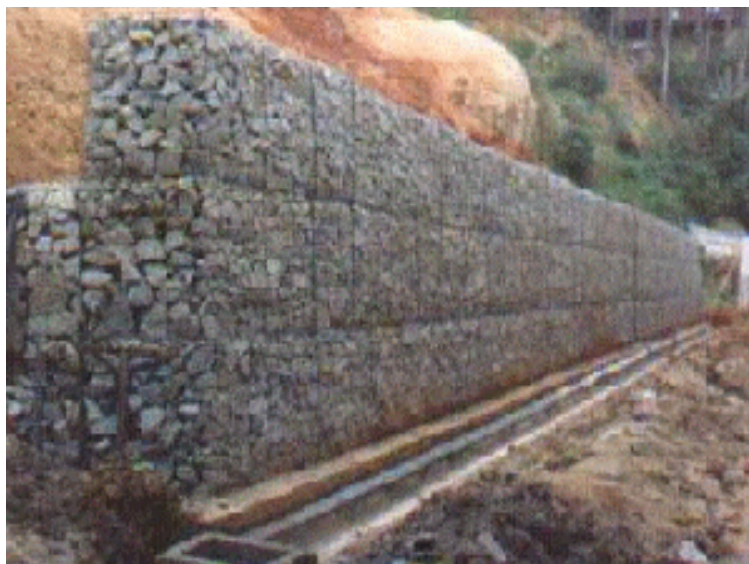
Figura 6: Muro de gabião
