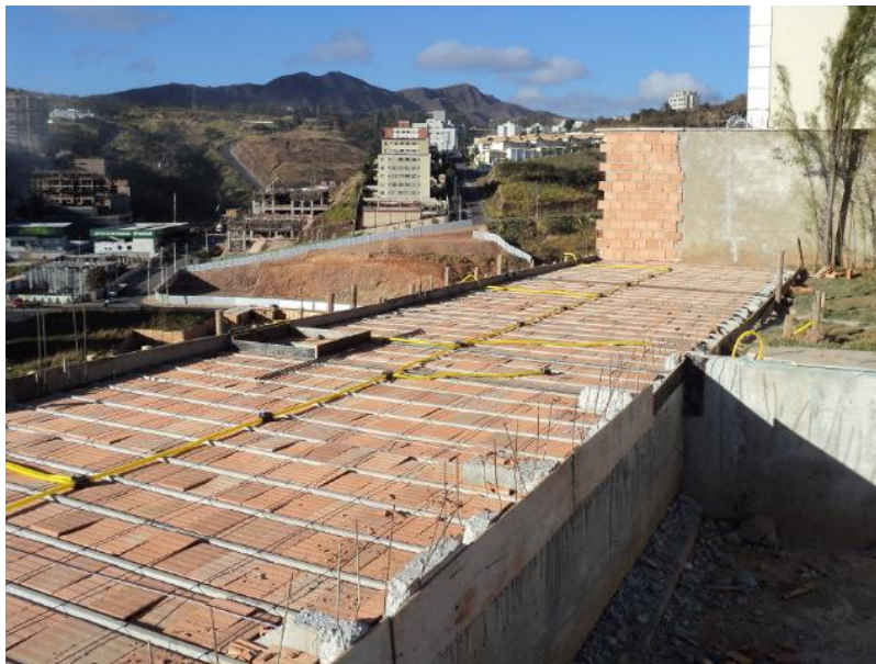
Figura 54: Laje área externa da edificação vizinha Fonte:O autor (2010)
