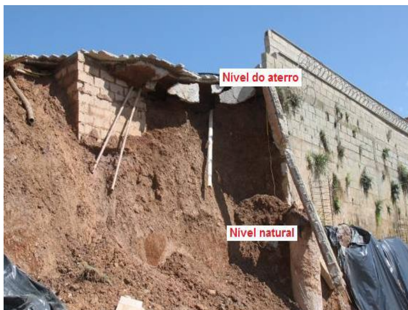
Figura 48: Nível do aterro Fonte: Parecer técnico – SARDINHA (2010)
