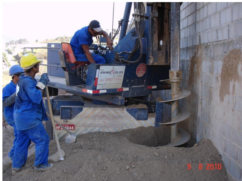
Figura 17: Escavação mecânica dos tubulões de contenção. Fonte:O autor (2010)
