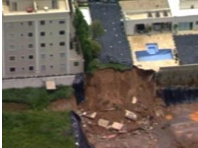
Figura 29: Vista superior da área afetada
