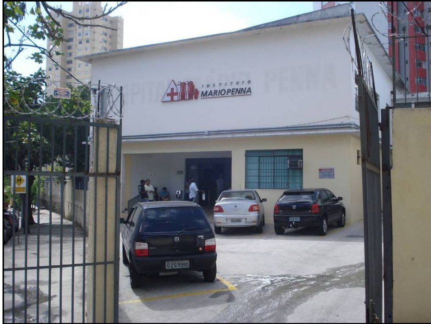
FIGURA 7: Foto externa da Unidade de Quimioterapia do Hospital Mário Penna, prédio anexo
