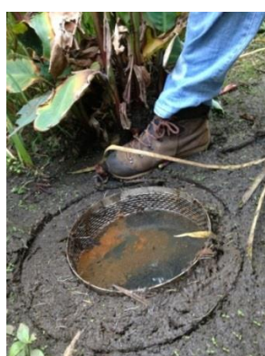
1 - Remoção da cesta móvel
