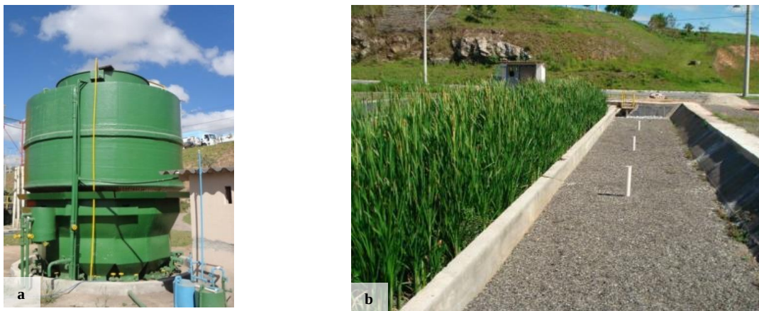
Figura 5.1. Reator UASB (a) seguido de SAC horizontal plantado e não plantado (b).
