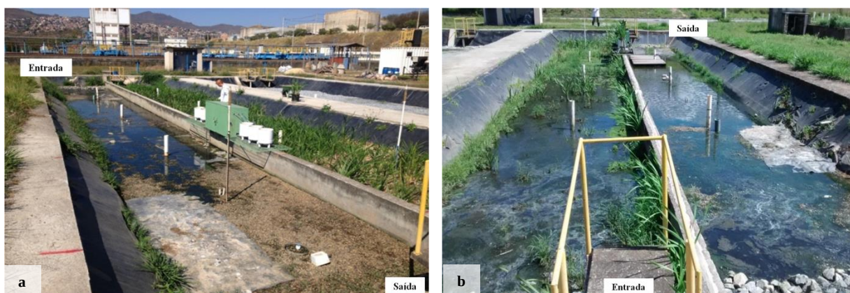
Figura 6.21. Situação do escoamento superficial em outubro/2014 (a) e dezembro/2014 (b).
