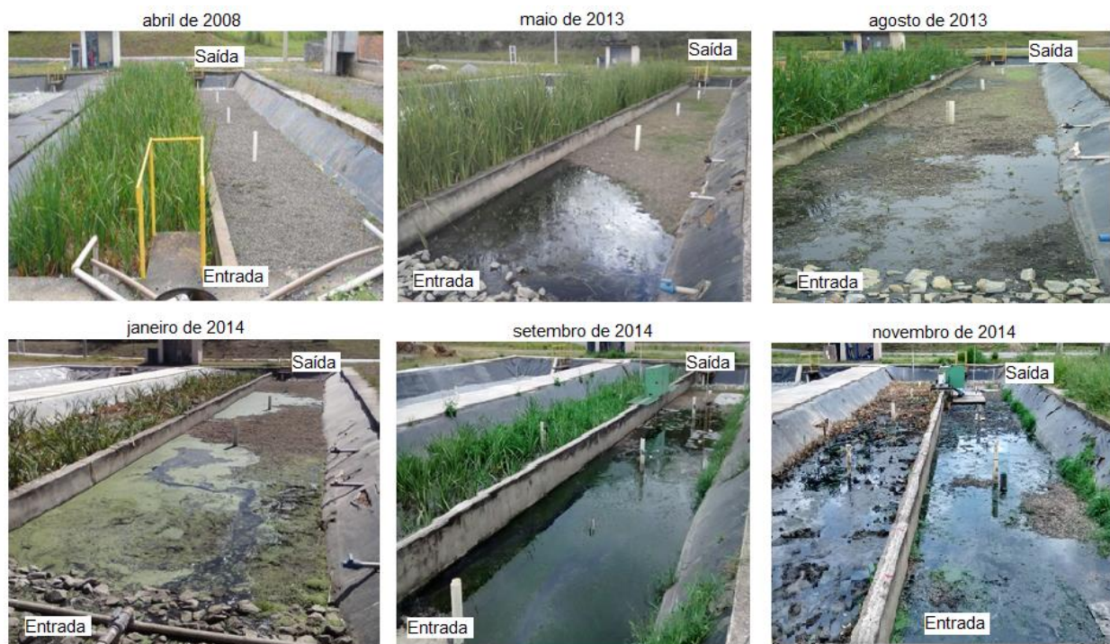
Figura 5.4. Evolução do escoamento superficial no Sistema Alagado Construído.
