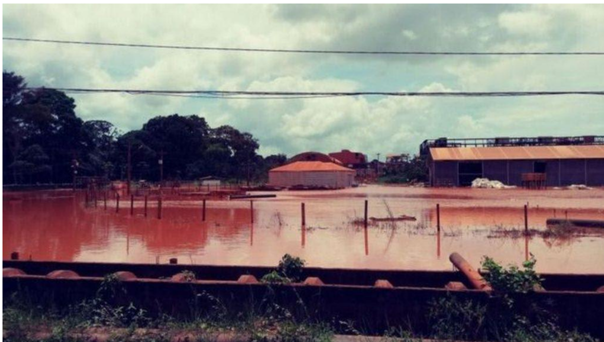
Figura 15: Registro da enchente em Barcarena
