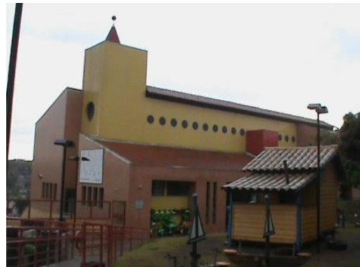
Figura 2: UMEI Rosa dos Ventos (vista do portão de entrada)
