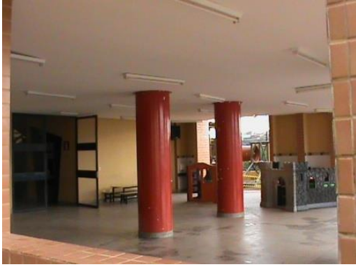
Figura 9: Vista parcial do pátio coberto (localizado aos fundos da instituição)
