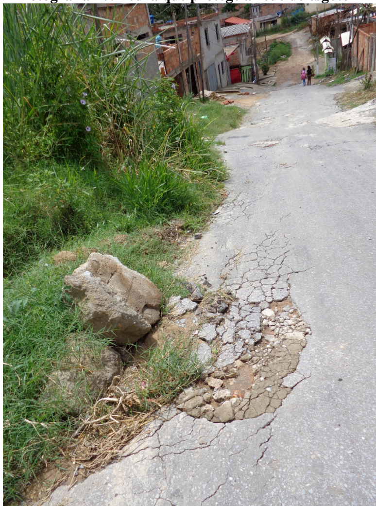
Fotografia 10: Pedra que protege a rede de esgoto 1
