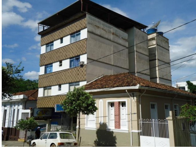
FIGURA 20 – Edifício Rua Doutor Francisco Barros, nº 75 Fonte: Acervo do autor, 2010
