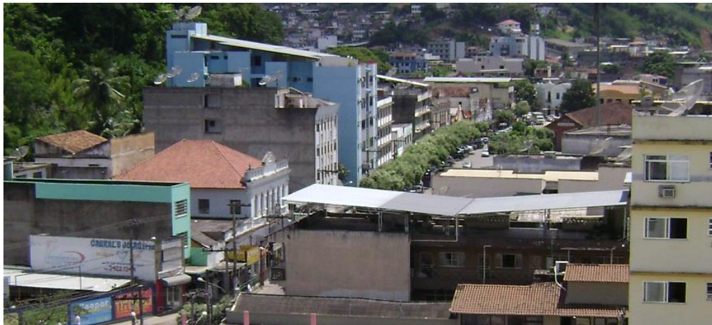
FIGURA 27 – Vista do correr de edificações na Praça Governador Valadares, face leste, com a inserção de edifícios de cinco e sete pavimentos Fonte: Acervo do autor, 2011
