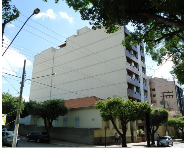
FIGURA 18 – Edifício Avenida Astolfo Dutra, nº 425 Fonte: Acervo do autor, 2011
