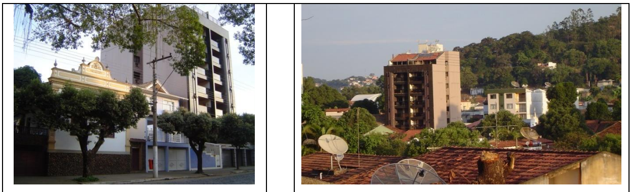
FIGURA 21 – Edifício Avenida Astolfo Dutra, nº 48. Vista de dois pontos distintos Fonte: Acervo do autor, 2011
