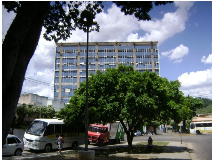
FIGURA 25 – Edifício Hospital de Cataguases. Avenida Coronel Antônio Augusto, nº 442, Vila Tereza Fonte: Acervo do autor, 2011
