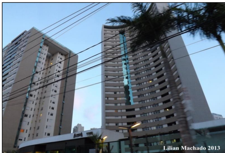
FIGURA 22 - Edificações construídas em área definida como ZEPAM.
