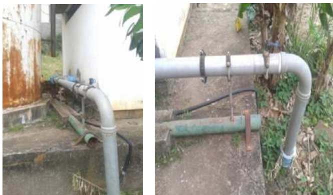
Figura 3 –Interceptação da sucção.
