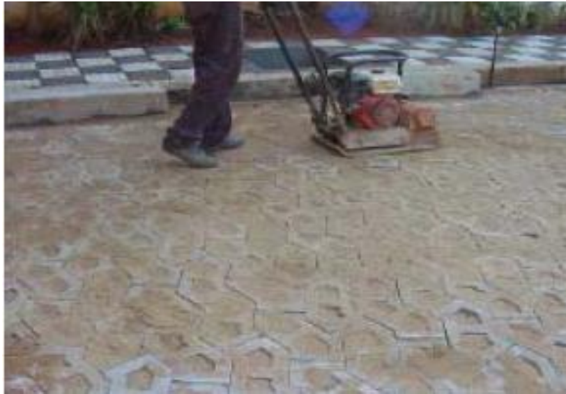
Figura 6.3 - Execução dos pavimentos intertravados drenantes (MALYSZ et al. , 2003).
