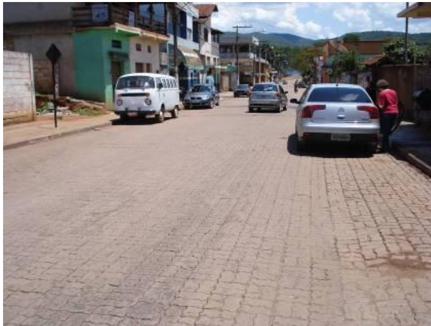
Figura 5.18 - Pavimento intertravado, Mário Campos (2008)
