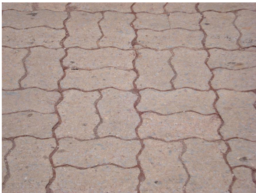
Figura 5.19 - Pavimento intertravado, Mário Campos (2008).
