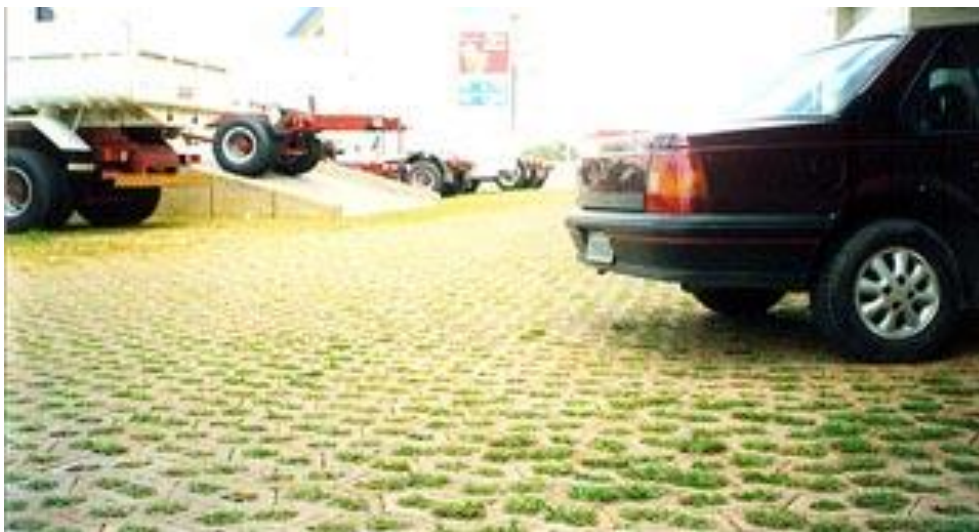
Figura 6.5 - Pavimento intertravado drenante, pisograma ( http://pavifort.net/produtos_paviverde.htm# ).
