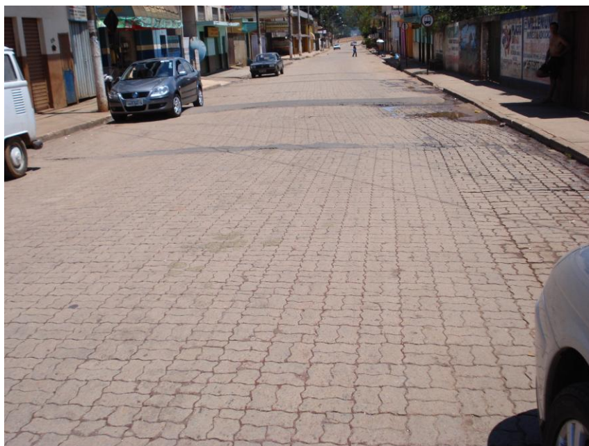
Figura 5.21 - Pavimento intertravado, Mário Campos (2008).
