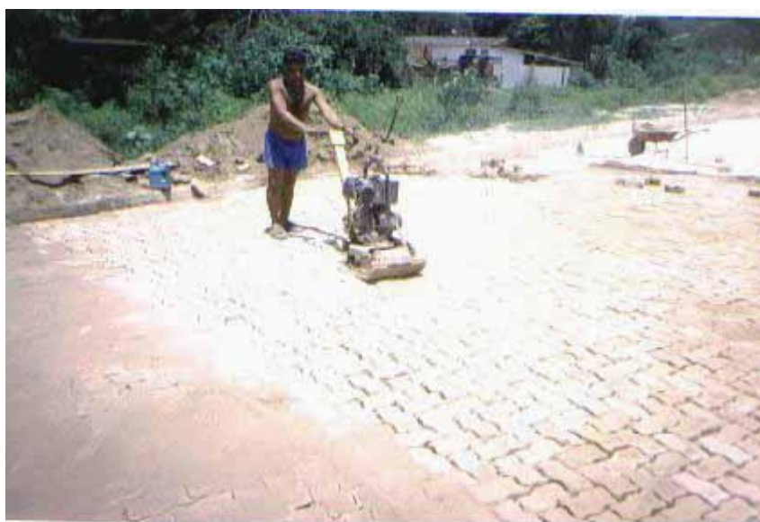
Figura 5.5 - Compactação do Pavimento Intertravado. Bairro Silva Prado, Brumadinho (2000).
