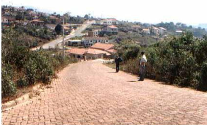
Figura 5.6 - Pavimento intertravado concluído, Bairro Silva Prado, Brumadinho (2000).
