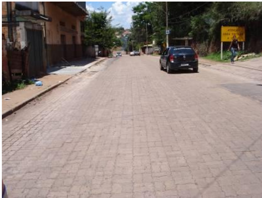
Figura 5.20 - Pavimento intertravado, Mário Campos (2008).
