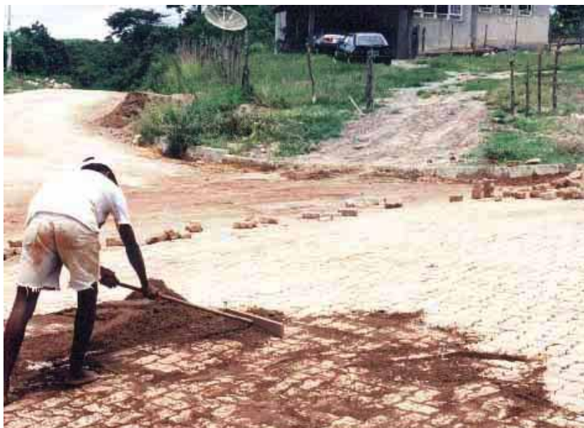
Figura 5.4 - Varrição do rejunte de areia. Bairro Silva Prado, Brumadinho (2000).
