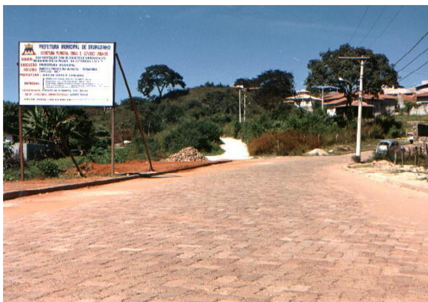
Figura 5.7 - Pavimento intertravado concluído, Bairro Silva Prado, Brumadinho (2000).
