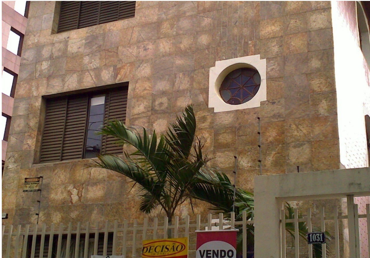
Figura 17 - Granito amarelo em acelerado processo de alteração com perda de cor (Branco, 2010).
