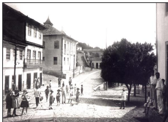
Figura 17: Ruas de Pedras com Pavimento Central, meados de 1902 (Diamantina - MG). Fonte: Arquivo Zé da Sé, 2020.
