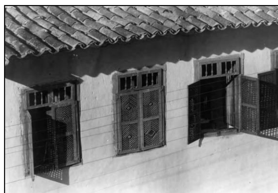
Figura 13: Exemplo de Gelosias em casas na Rua do Carmo, 1920 (Diamantina - MG). Fonte: IPHAN, 2020.
