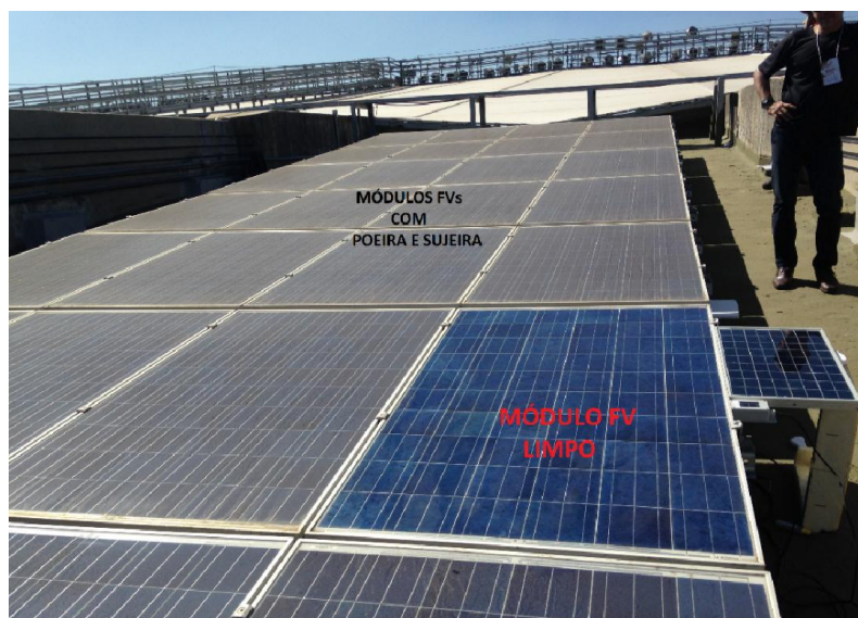
Figura 7.33 –Módulo FV limpo.
