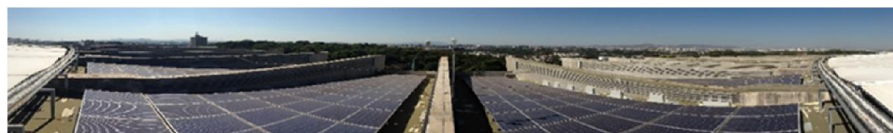
Figura 7.6 – (a) Usina solar fotovoltaica; (b) Segmentos com os geradores fotovoltaicos ( strings ) no telhado.
