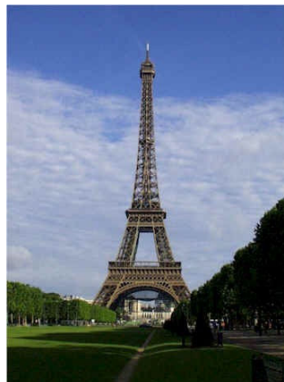
FIGURA 03 - Exemplo de estrutura Treliçada
