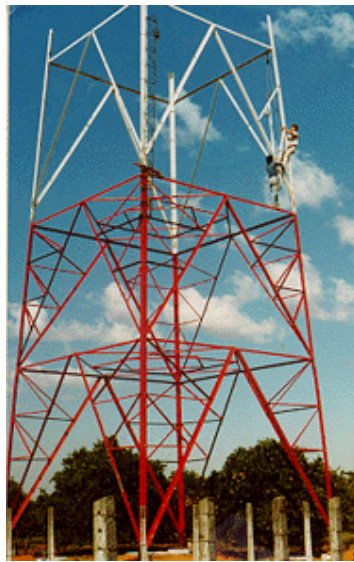
FIGURA 02 - Exemplo de estrutura Treliçada
