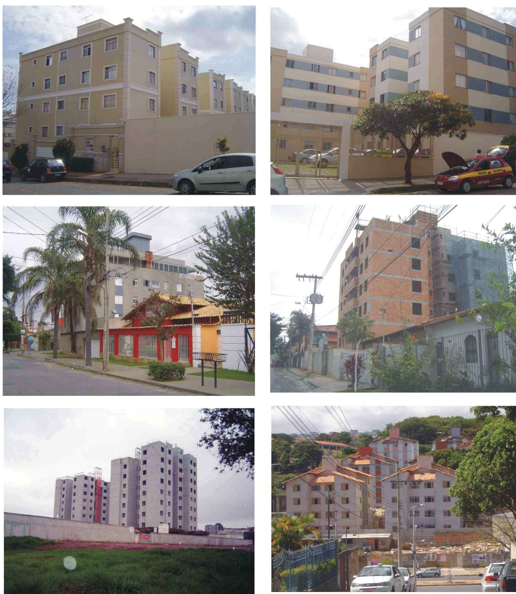
FIGURA 34 - Edificações verticais recentes – transformações na paisagem urbana local Fonte: Almeida, 2009. Visita a campo (01/05/2009).
