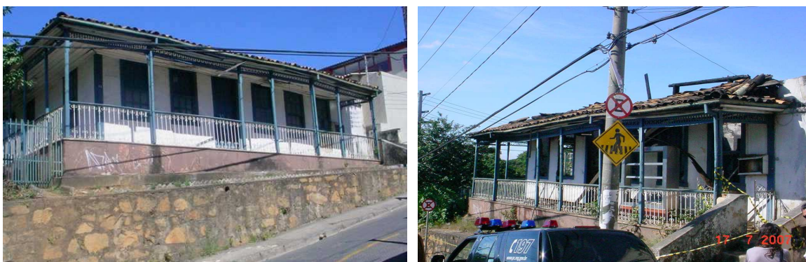
FIGURA 39 - Fotos do Casarão Boa Vista, antes e após incêndio em 2007 Fonte: Belo Horizonte, 2008.
