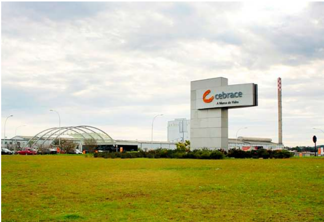
Figura 13: Fabrica da Cebrace em Jacareí, SP.
