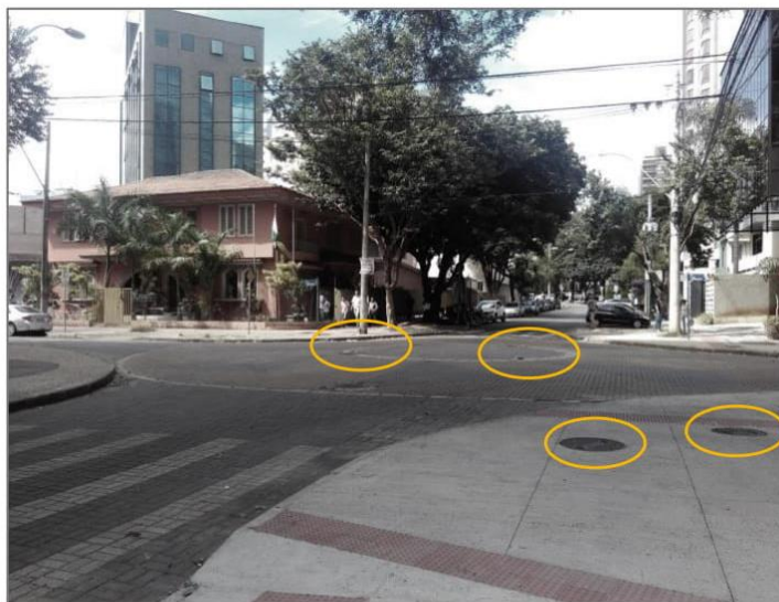
Cruzamento Rua Paraíba com Bernardo Guimarães. Em destaque bocas de lobo
