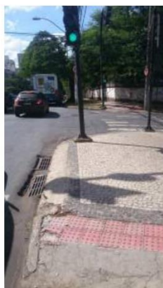
Imagem 8: Boca de lobo anterior à rua Josafá Belo, Cidade Jardim. Fonte: Acervo do autor.
