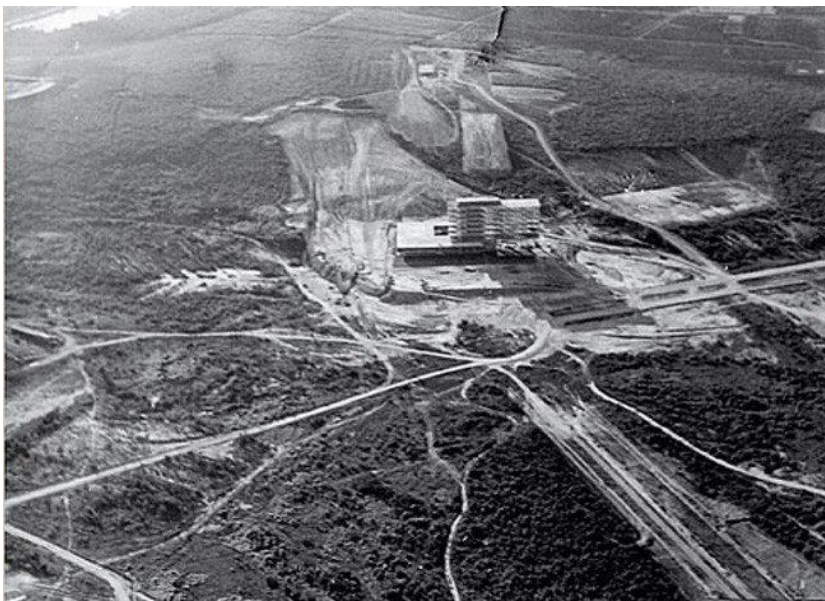
Figura 31: Obras de movimentação de terra no campus UFMG, em meados da década de 1950. Fonte: Acervo TV UFMG / Cedecom.
