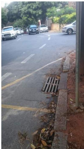
Imagem 18: Boca de lobo recebendo folhas, evidenciando falta de manutenção. Falta de calha na pista. Rua Josafá Belo, Cidade Jardim. Fonte: Acervo do autor.
