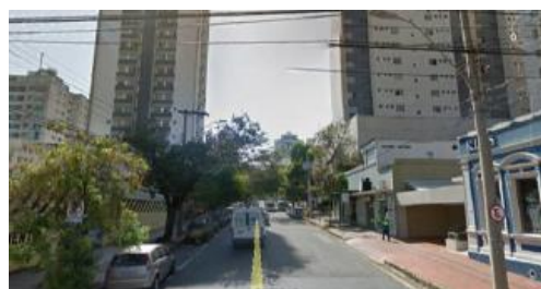
Imagem da condição real, observada da Rua dos Aimorés
