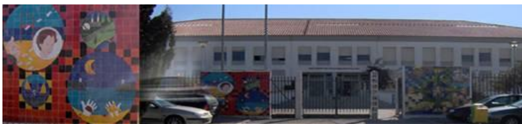
Painel em detalhe e fachada principal da Escola Secundária Poeta Al Berto em Sines
