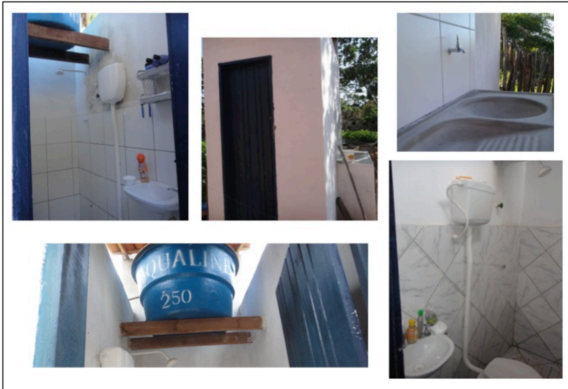
Figura 5.12 - Banheiros individuais construídos nos domicílios de Cristais
