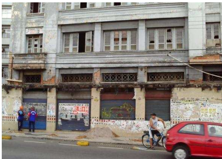
Figura 54 – Pavimento térreo do Ed. Pouso Real antes da reabilitação. Apresentava-se bastante descaracterizado da composição original. 2006. Fonte: SEHAB/PMV.
