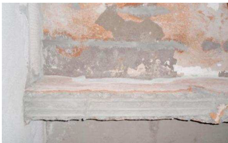
Figura 122 - Viga da última laje do Ed. Tabajara. Após aplicação de produto para tratamento da ferrugem. 2011.
