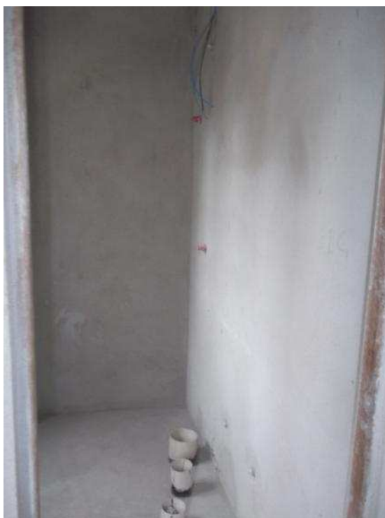
Figura 104 - Banheiro junto à fachada, onde estavam previstas cozinha e área de serviço. Fonte: Arquivo pessoal da autora. 2011.
