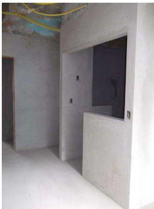
Figura 108 - Entrada da cozinha e área de serviço. Parede que separa sala e cozinha, após abertura do vão para iluminação e ventilação. 2011.
