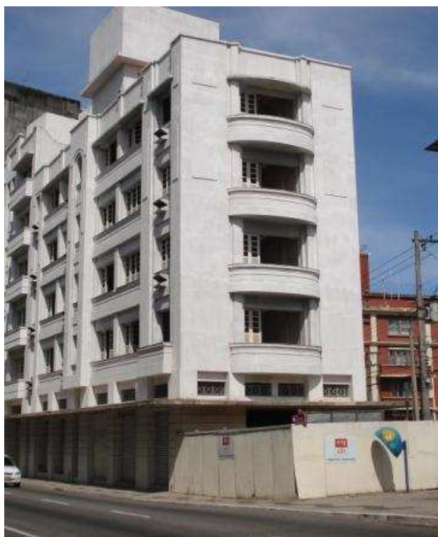
Figura 57 - Edifício Pouso Real durante a obra de reabilitação. Nov./2011.
