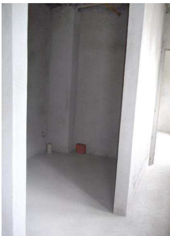
Figura 103 - Cozinha e área de serviços após alterações na planta dos apartamentos da coluna 04 do Ed. Pouso Real. 2011.
