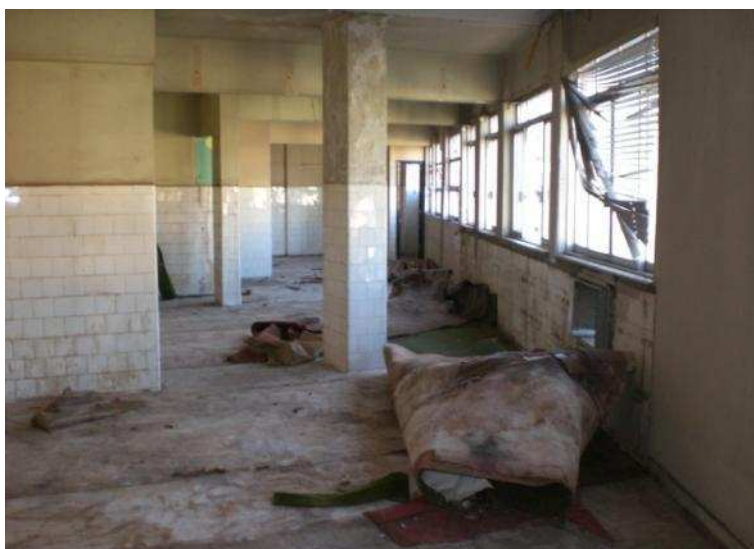
Figura 27 – Paredes revestidas com azulejo até meia altura. Observam-se também restos do antigo carpete que foi descolado do piso. O sistema estrutural utilizado (viga-pilar) também fica evidente nesta imagem. 2007. Fonte: SEHAB/PMV.
