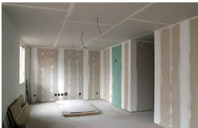
Figura 11 – Vedação interna em gesso acartonado, após fixação dos painéis.
