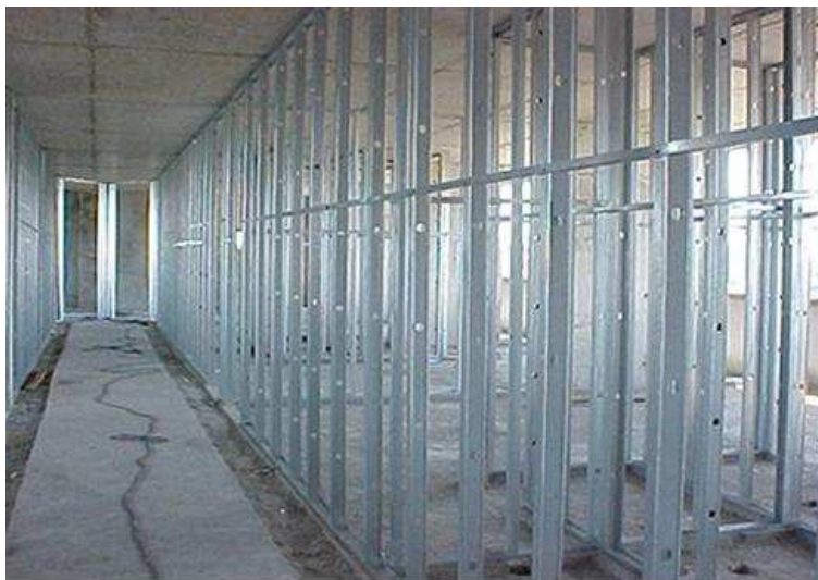
Figura 10 – Vedação interna em gesso acartonado. Perfis metálicos para fixação dos painéis.
