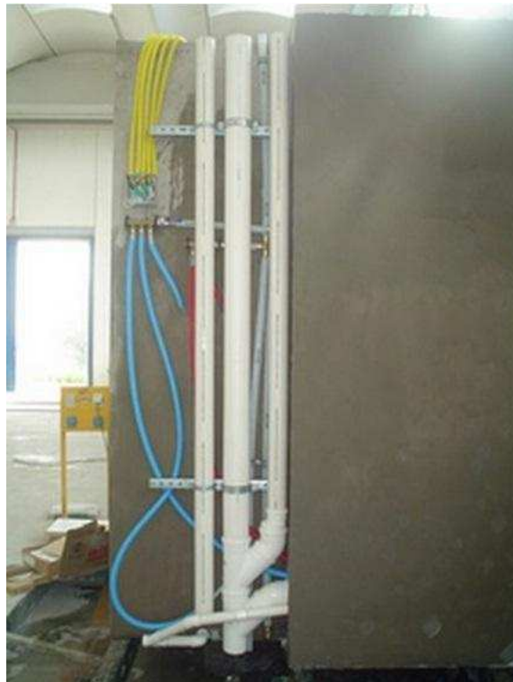
Figura 17 - Instalação de água e esgoto em banheiro produzido fora do canteiro de obras.
