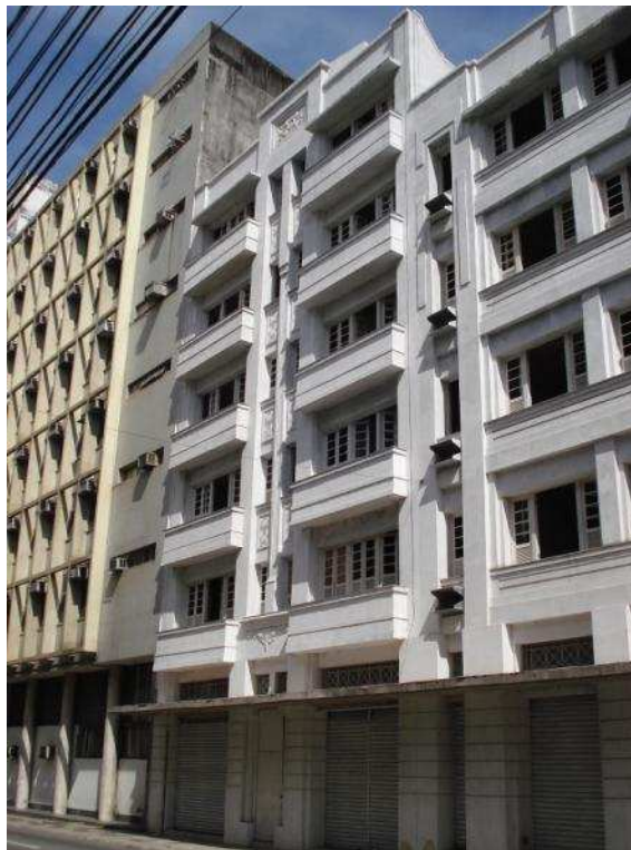
Figura 76 – Ed. Tabajara na fase final (acabamento) da reabilitação. Nov./2011.
