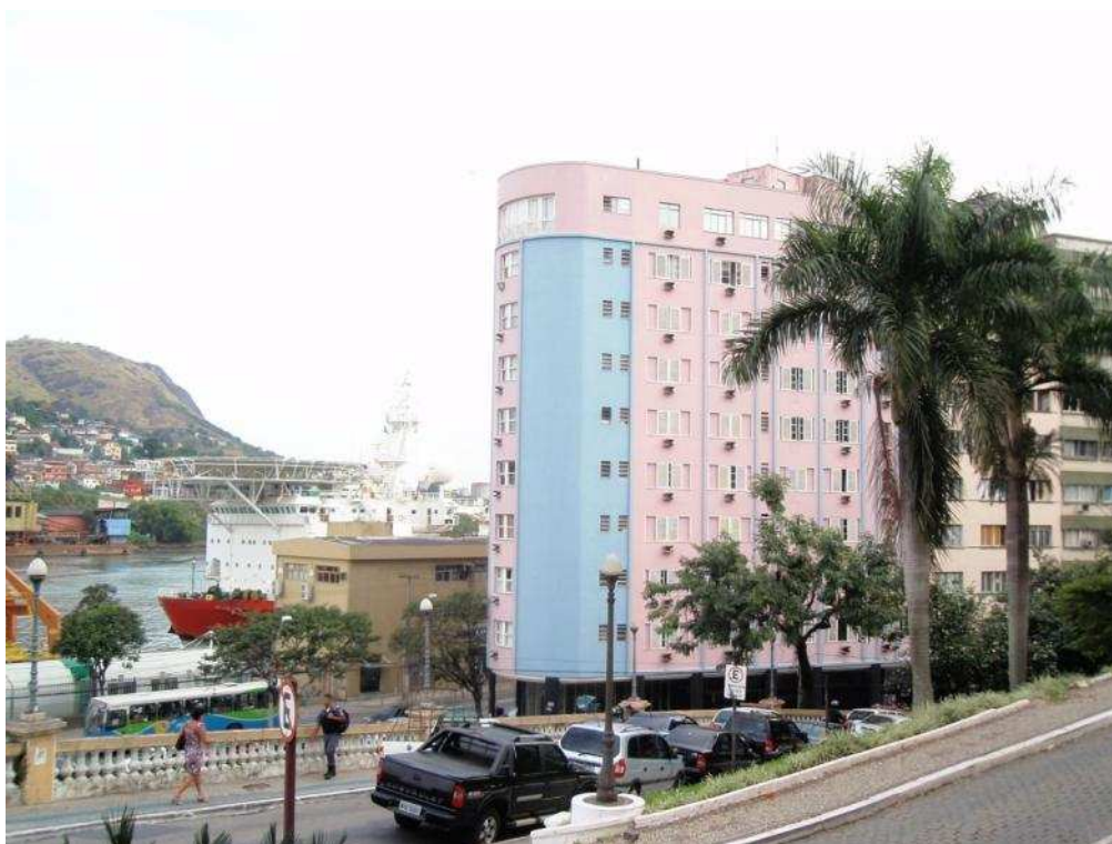
Figura 21 - Edifício Estoril (após reabilitação) visto da escadaria de acesso ao Palácio Anchieta. Ao fundo a baía de Vitória e o Porto homônimo. Fonte: Arquivo pessoal da autora. 2011.
