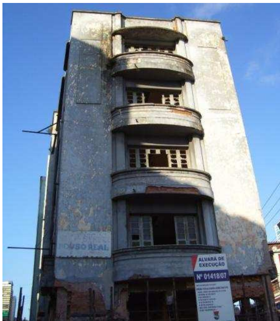
Figura 55 – Edifício Pouso Real antes da reabilitação. 2006. Fonte: SEHAB/PMV.
