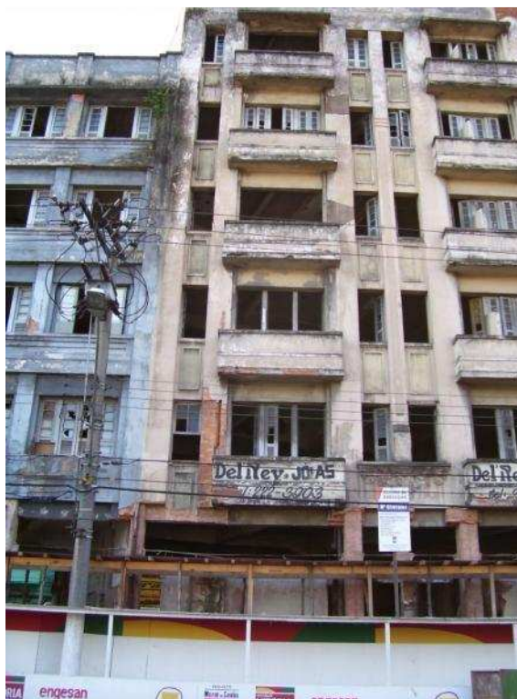
Figura 73 – Ed. Tabajara no início da reabilitação, ainda muito deteriorado. 2007. Fonte: SEHAB/PMV.
