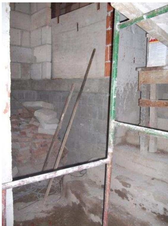
Figura 102 – Hall de entrada do Ed. Tabajara. Escada de acesso ao hall do elevador e espaço onde será instalada a plataforma elevatória. Fonte: Arquivo pessoal da autora. 2011.
