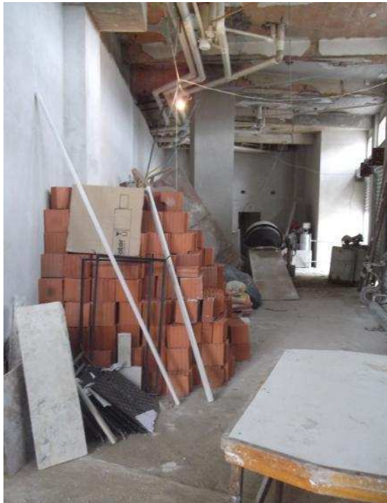
Figura 130 - Canteiro de obras do Edifício Pouso Real. Pavimento térreo. 2011.
