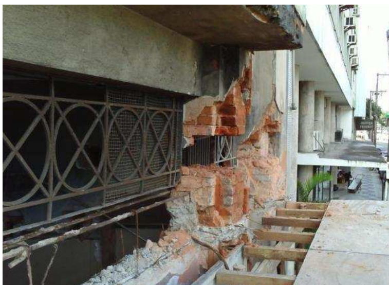
Figura 50 – Alvenaria em tijolo cerâmico maciço e gradil do Ed. Pouso Real. 2008. Fonte: SEHAB/PMV.
