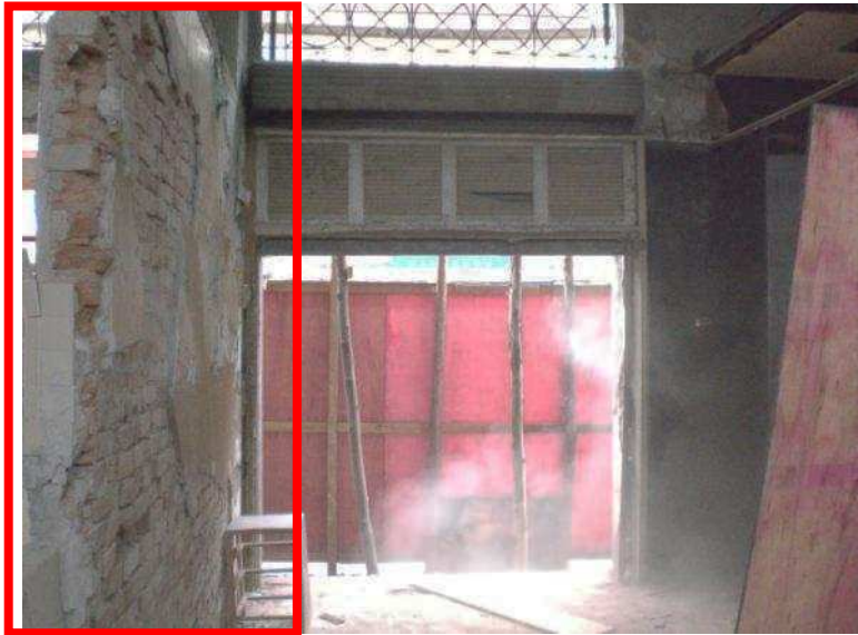
Figura 71 - Pavimento térreo do Ed. Tabajara, na etapa de demolição. Destacado em vermelho a alvenaria em tijolo maciço aparente, à esquerda. 2007. Fonte: SEHAB/PMV.
