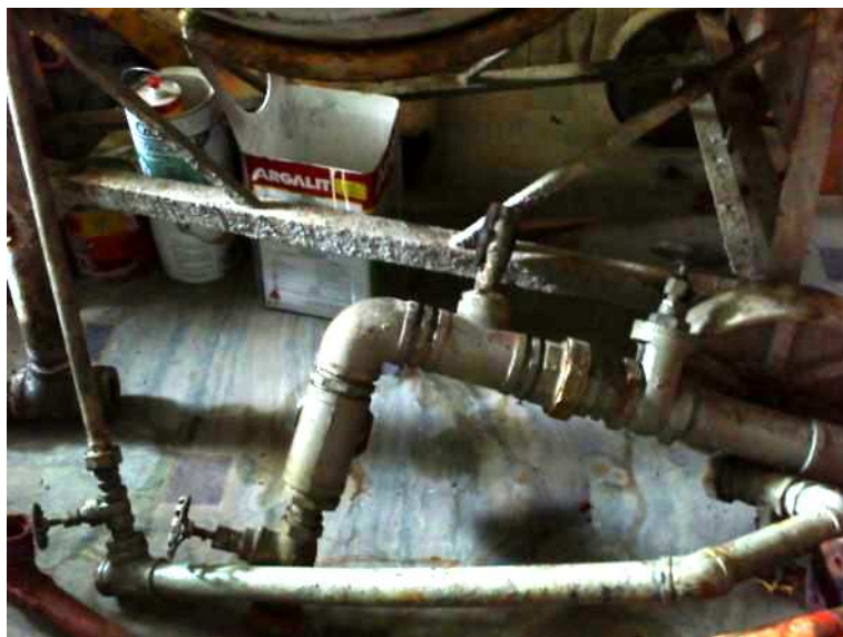
Figura 30 - Sobras da tubulação em ferro retirada do Ed. Estoril. 2008.
