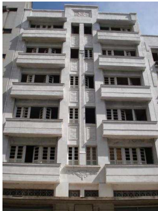
Figura 64 - Fachada do Ed. Tabajara voltada para a av. Jerônimo Monteiro. Observa-se a marcação do acesso ao edifício no centro e a presença das varandas fortalece a simetria da composição da fachada. Nov./2011.
