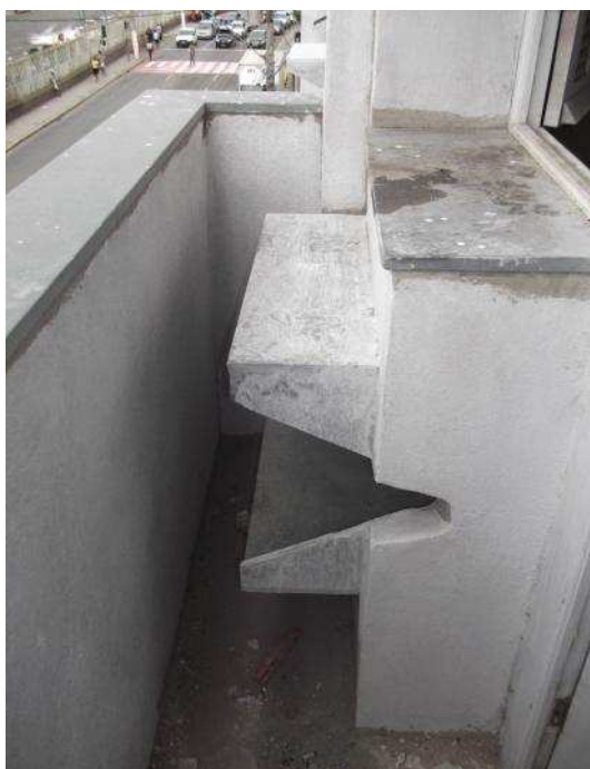
Figura 127 – Edifício Tabajara. Caixa para instalação de aparelho de ar condicionado. Instalada por dentro da varanda e abaixo da esquadria. 2011.
