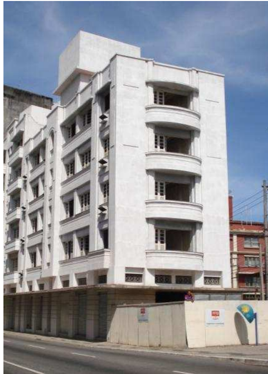
Figura 39 – Edifício Pouso Real durante a reabilitação. Fachada voltada para a av. Jerônimo Monteiro e fachada da esquina. Nov./2011. Fonte: Arquivo pessoa.
