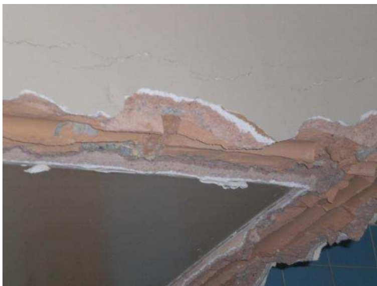
Figura 24 - Fundo de uma viga do Ed. Estoril e restos da alvenaria existente antes da demolição. 2007. Fonte: SEHA/PMV.
