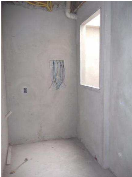
Figura 114 – Fosso de iluminação e ventilação no Ed. Tabajara. Área de serviço do apartamento 504. 2011.
