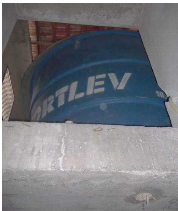
Figura 111 – Espaço embaixo do telhado que será retirado para acrescentar mais um reservatório de água. 2011.
