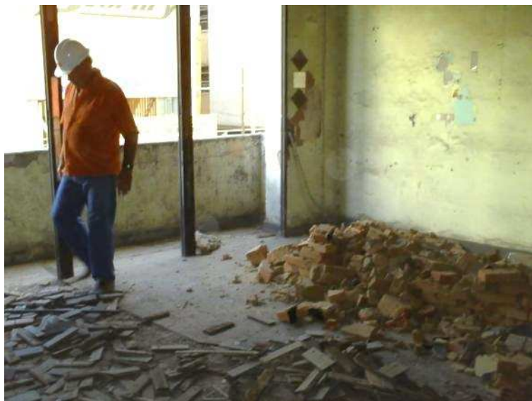
Figura 74 - Pavimento superior do Ed. Tabajara. À esquerda, revestimento de piso em tacos de madeira removido e, à direita, sobras da demolição das alvenarias internas. As paredes internas eram rebocadas e pintadas. 2008. Fonte: SEHAB/PMV.
