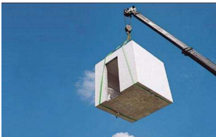
Figura 18 – Banheiro sendo içado até o pavimento de destino. Fonte: http://mundoparamorar.com.br/2011/06/24/banheiro-pronto/ . Acessado em: 16/11/2011.
