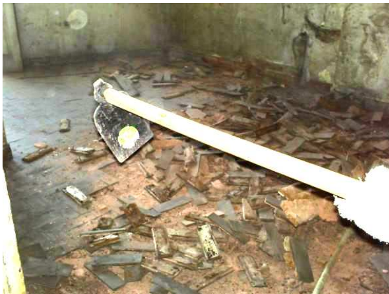
Figura 53 – Piso em taco sendo removido no Ed. Pouso Real. 2008. Fonte: SEHAB/PMV.
