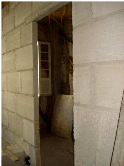
Figura 131 - Alvenaria em bloco de concreto celular. Ed. Pouso Real. 2011.
