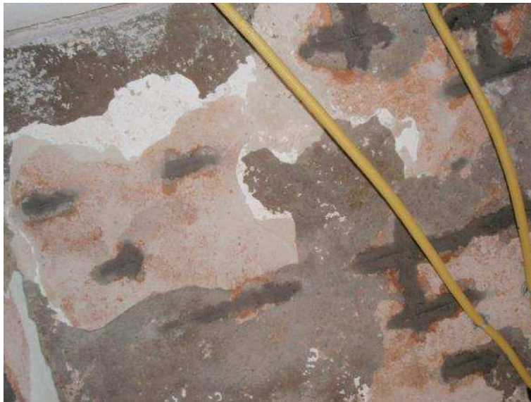
Figura 121 – Tratamento da ferragem que sofreu corrosão. 2011.
