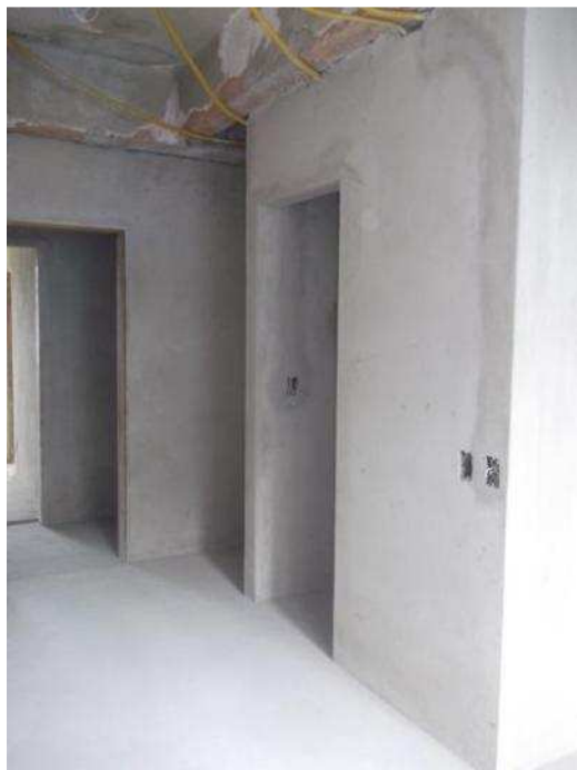
Figura 107 – Entrada da cozinha e área de serviço. Parede que separa sala e cozinha antes da abertura do vão de iluminação e ventilação. 2011,
