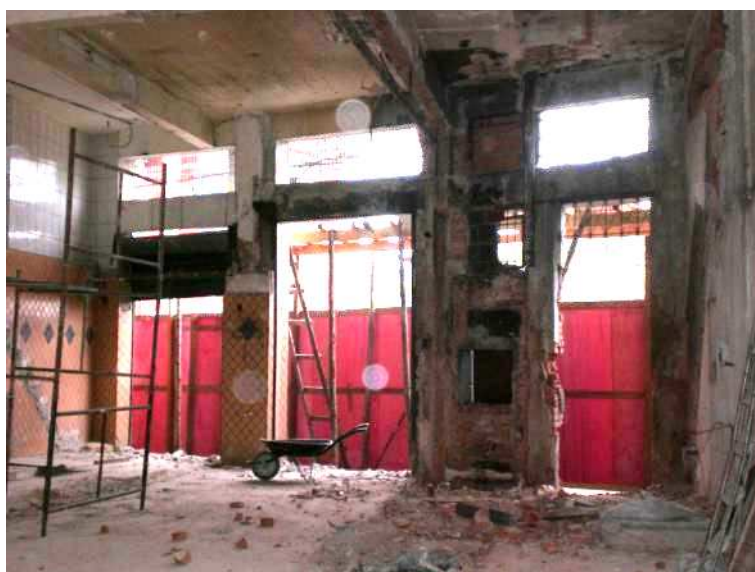
Figura 70 - Pavimento térreo do Ed. Tabajara. Observam-se as vigas sob a laje de teto. 2007. Fonte: SEHAB/PMV.
