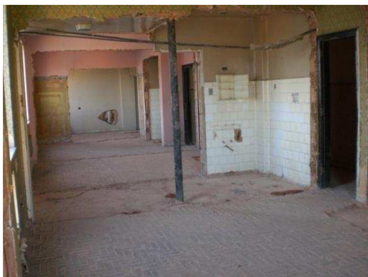
Figura 31 - Tubo de queda (centro) em ferro, Edifício Estoril. 2008.
