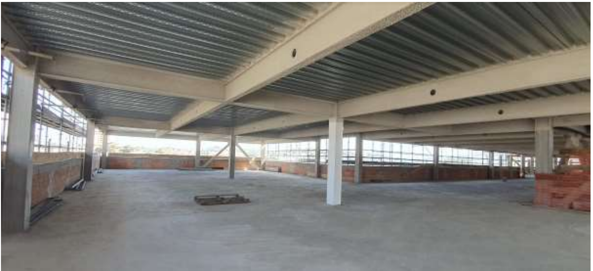
Figura 14 – Vista dos pisos compreendidos entre os eixos A e C.
