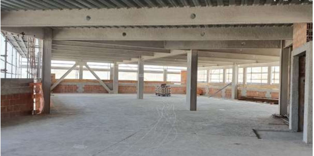
Figura 13 – Vista dos pisos compreendidos entre os eixos 1' e 3'.
