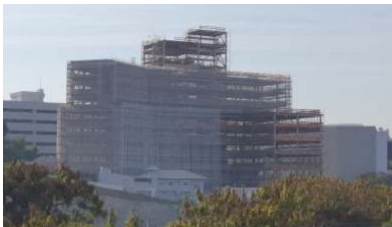
Figura 9 – Fachada do edifício em construção.
