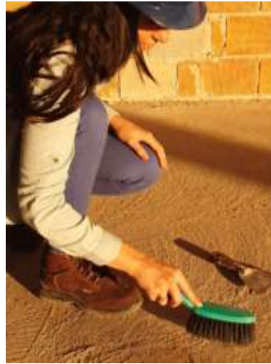
b) Limpeza da superfície
