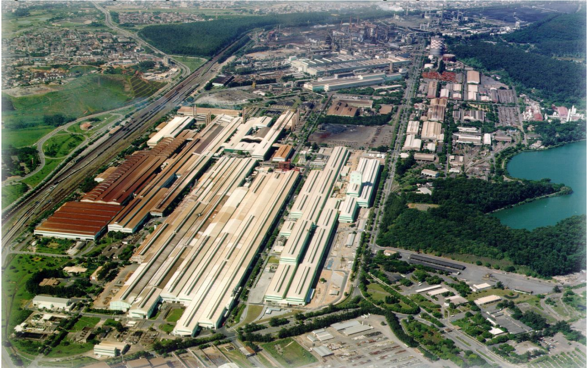
Figura 22 - Vista geral da planta industrial da Usiminas em Ipatinga - Minas Gerais
