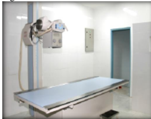
Figura 09 - Sala de raios-X
