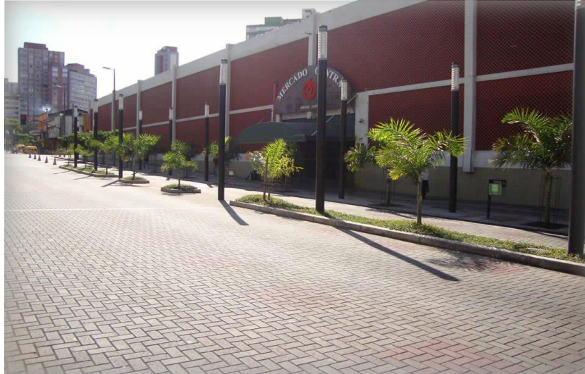
Figura 34 - Assentamento pisos intertravados avenida Augusto de Lima, Belo Horizonte MG
