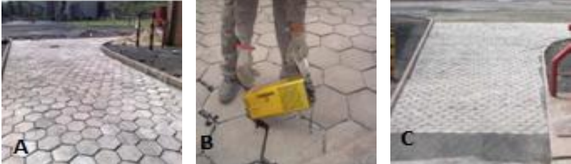
Figura 20 - (a) término do assentamento; (b) rejunte betuminoso; (c) finalização da pavimentação
