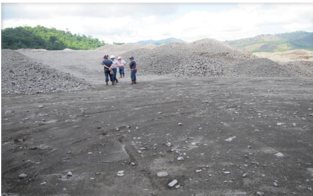
Figura 48 - Pátio 03 de armazenamento de escória de aciaria , Ipatinga/MG
