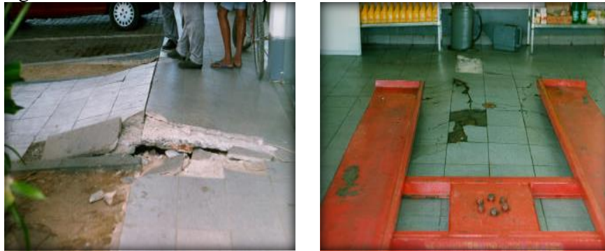
Figura 06 - Fenômenos da expansibilidade do uso da escória de aciaria
