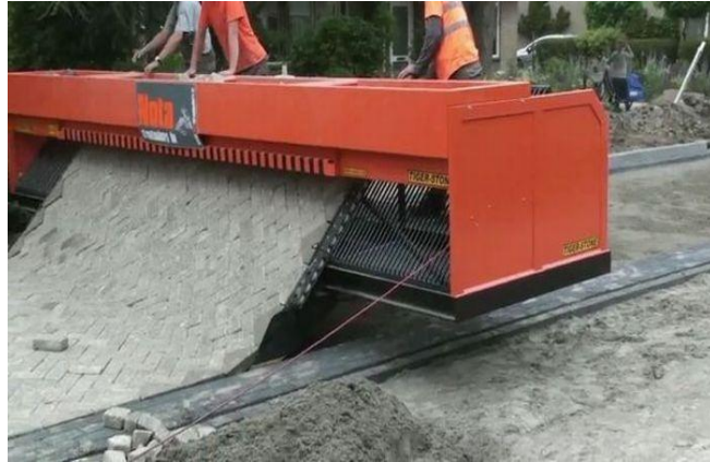
Figura 17 - Assentamento de piso intertravado mecanizado na Alemanha
