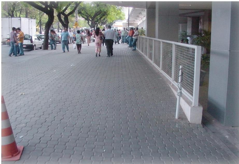
Figura 33 - Pisos intertravados instalados no Chevrolet Hall - Belo Horizonte MG
