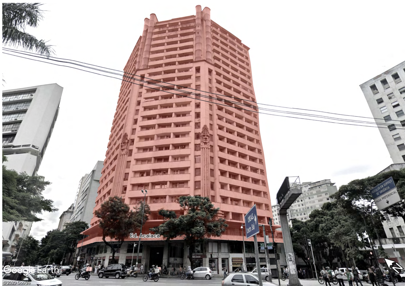
Figura 31: Área de interesse 11 – vista da rua (Ed. Acaiaca). Fonte: Google Street View [data de referência: abril de 2019]. Modificado pela autora.
