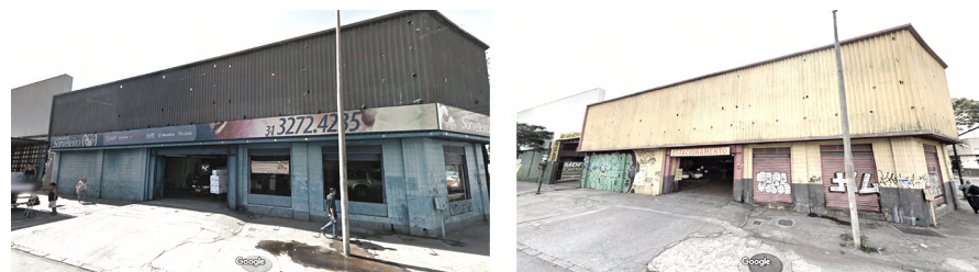
Figura 7: Edifício convertido em estacionamento na Área 29.
