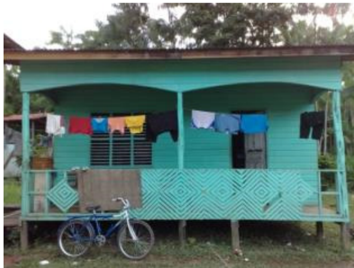
Figura 22-Exemplificação de tipologia de casa do tipo com ripas de sentido horizontal, uso de varanda e com caimento lateral do telhado Fonte: IPHAN, 2009
