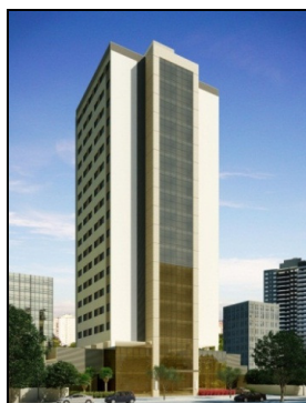
Figura 20 - Vista da Obra 5
