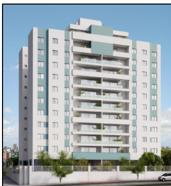
Figura 16 - Vista da Obra 2
