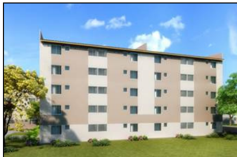
Figura 18 - Vista da Obra 3
