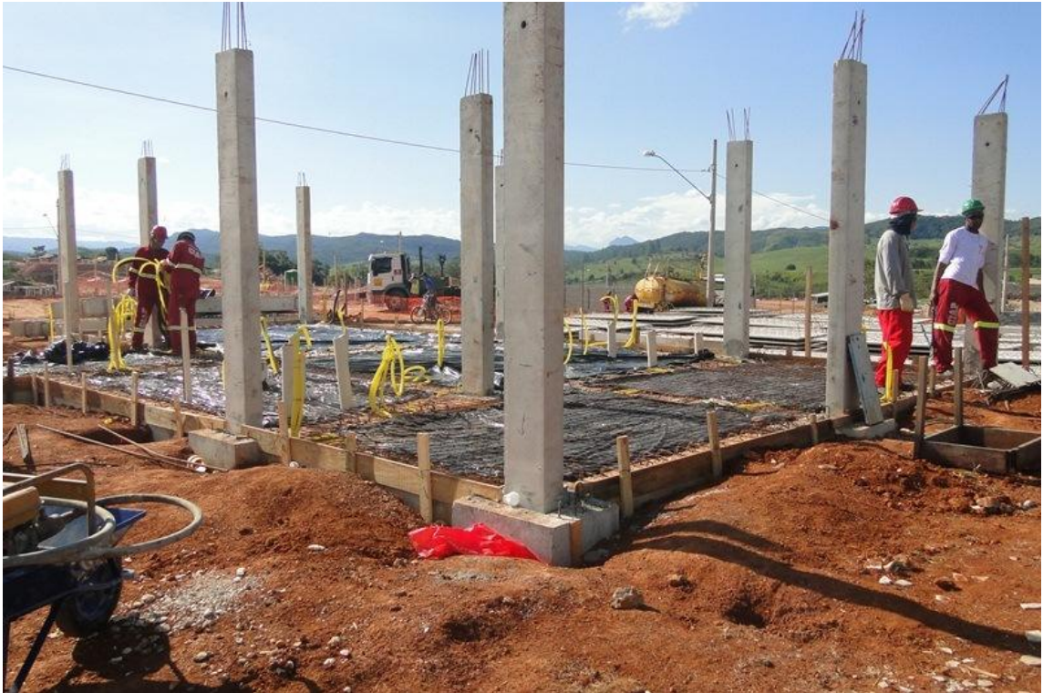
Figura 5- Montagem de estruturas pré fabricadas. Fonte: arquivo pessoal
