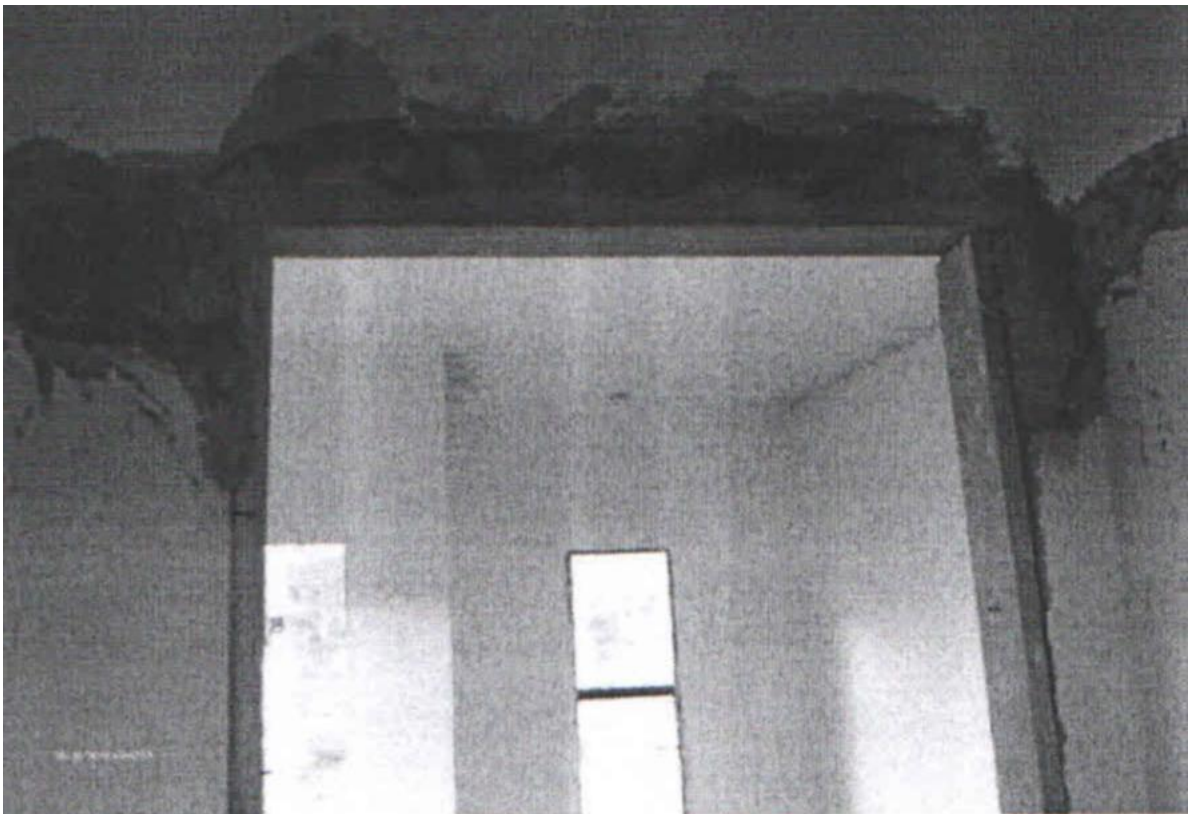
Figura 22- Execução de verga. Fonte: arquivo pessoal
