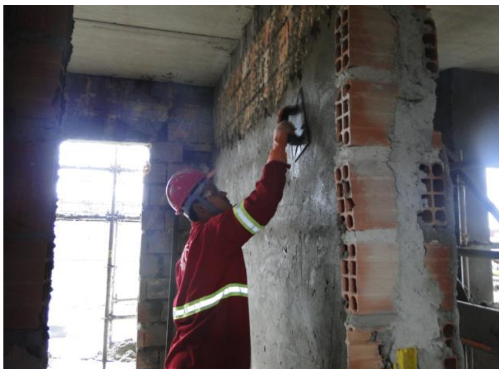
Figura 16- Reboco. Fonte: arquivo pessoal
