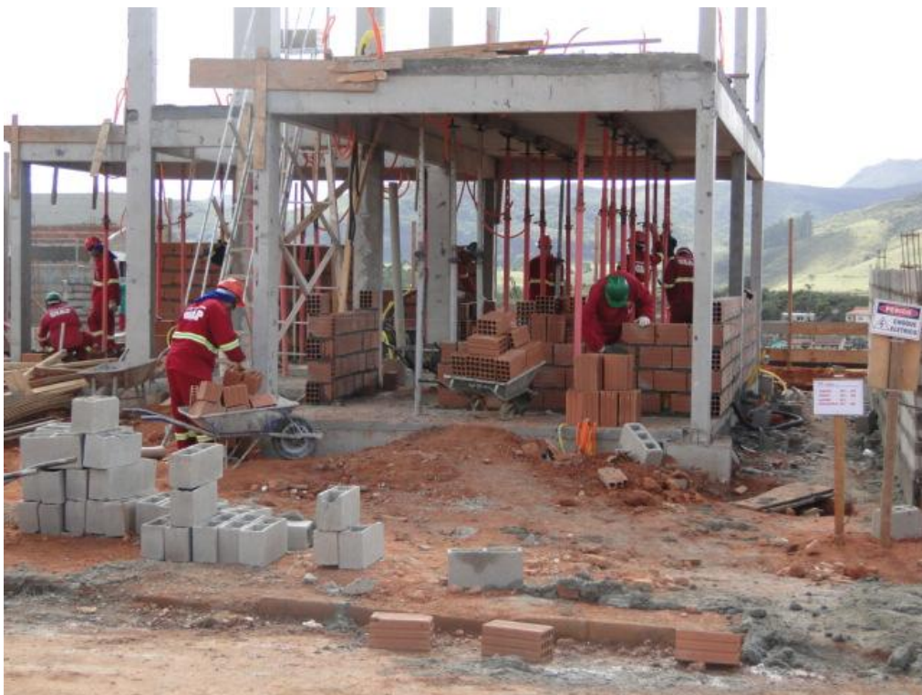
Figura 11- Alvenaria primeiro pavimento. Fonte: arquivo pessoal
