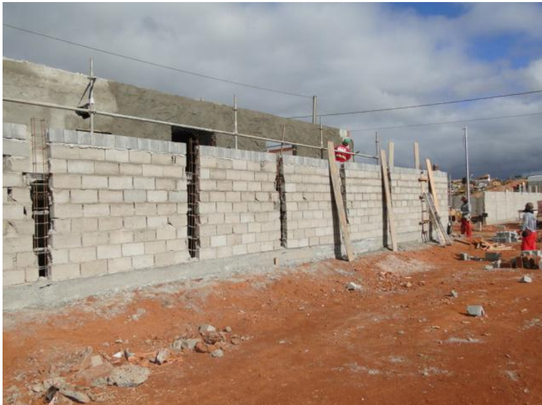
Figura 18- Reboco externo. Fonte: arquivo pessoal
