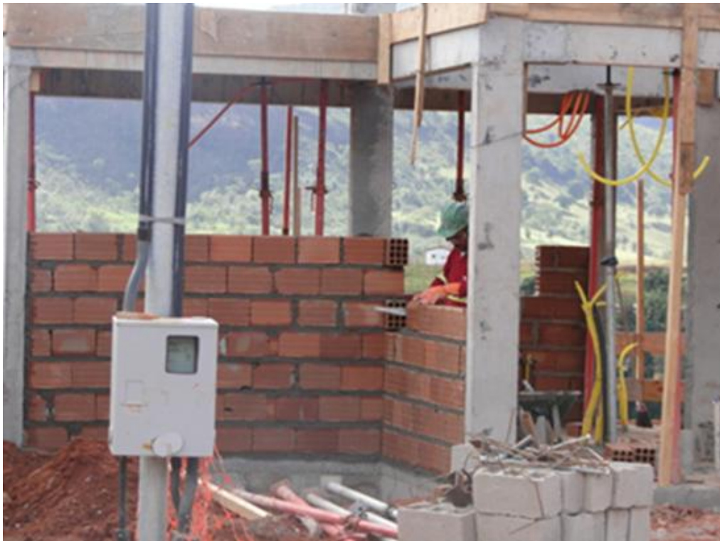
Figura 9- Alvenaria de vedação. Fonte: arquivo pessoal
