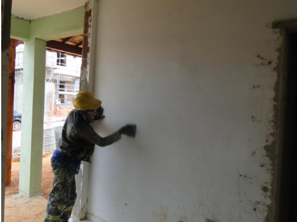
Figura 13- Amassamento em gesso. Fonte: arquivo pessoal
