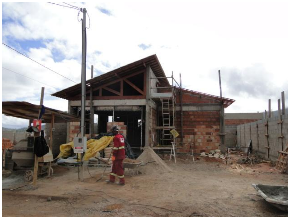
Figura 12- Vista geral alvenaria. Fonte: arquivo pessoal
