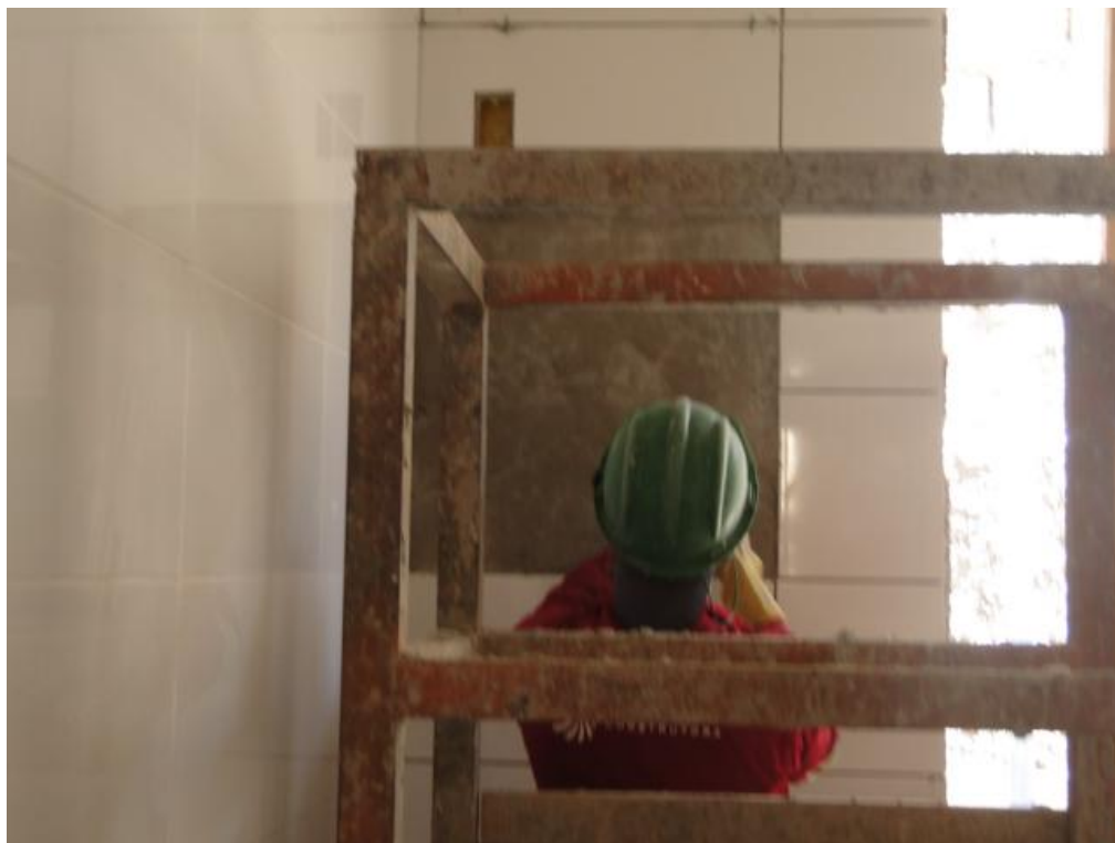
Figura 15- Assentamento cerâmica na parede. Fonte: arquivo pessoal
