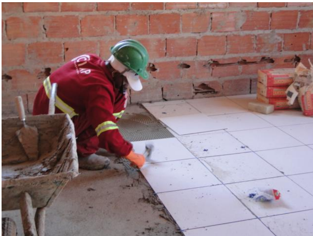
Figura 20- Assentamento de cerâmica de piso. Fonte arquivo pessoal
