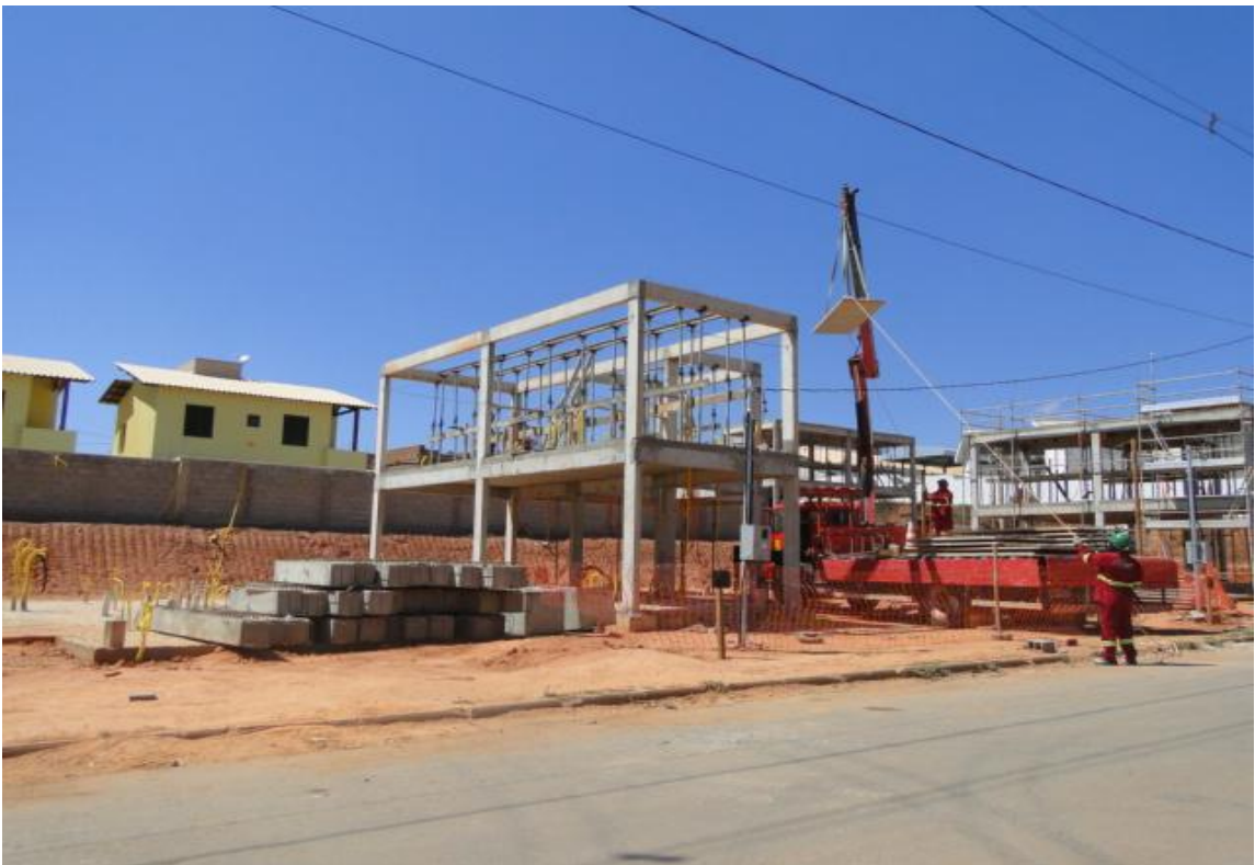
Figura 7- Montagem de laje. Fonte: arquivo pessoal
