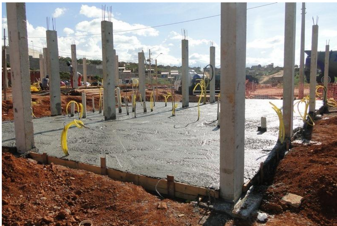
Figura 8- Concretagem de laje de piso. Fonte: arquivo pessoal
