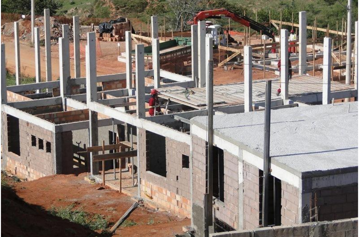
Figura 6- Montagem de estruturas e lajes pré fabricada. Fonte: arquivo pessoal
