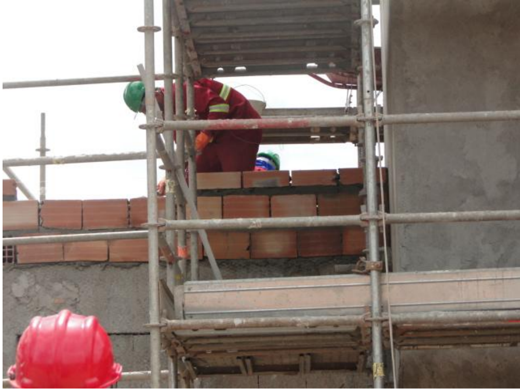
Figura 10- Alvenaria segundo pavimento. Fonte: arquivo pessoal
