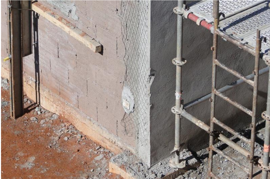
Figura 17- Chapisco e reboco sobre tela. Fonte: arquivo pessoal
