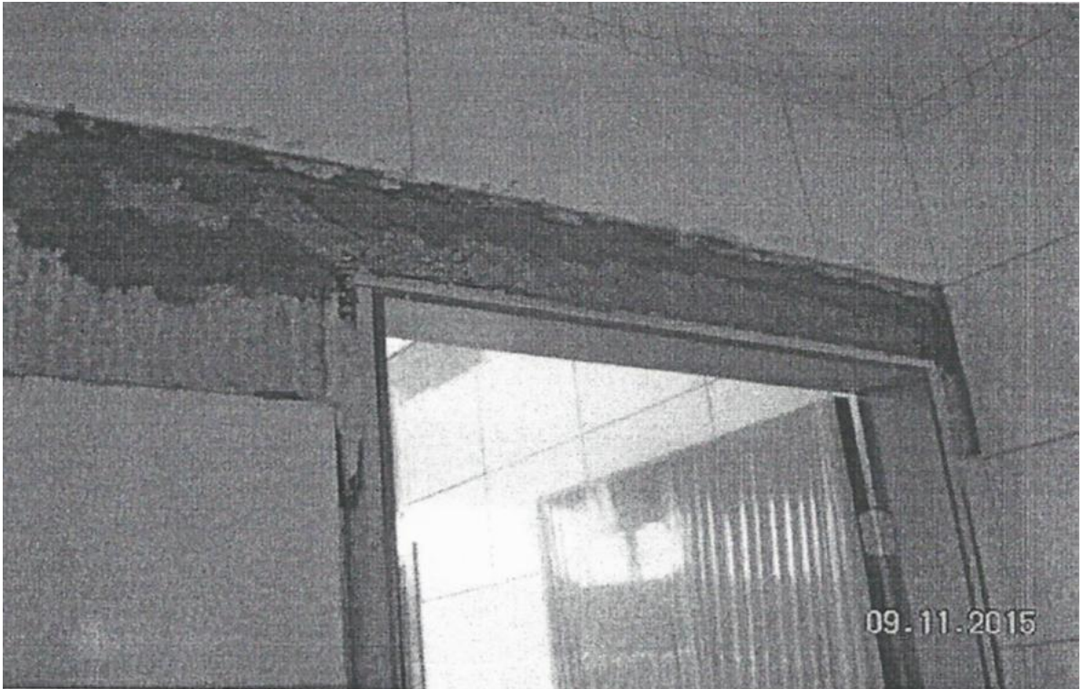
Figura 21- Execução de verga. Fonte: arquivo pessoal
