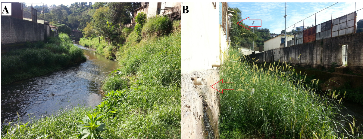
FIGURA 13 – Córrego Tripuí próximo ao Bairro Barra (A); Presença de casas e lançamento de efluentes domésticos no Córrego (B).
