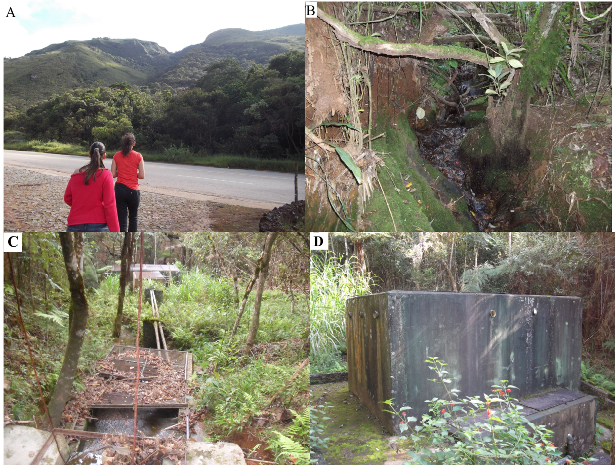
FIGURA 7 – Localização e entrada da nascente, propriedade particular do SESC – MG (A); nascente do Córrego Tripuí (B); e Barramento de drenagem próximo à nascente (C e D).
