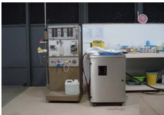
Figura 15 – Máquina de Hemodiálise e estação de tratamento de água
