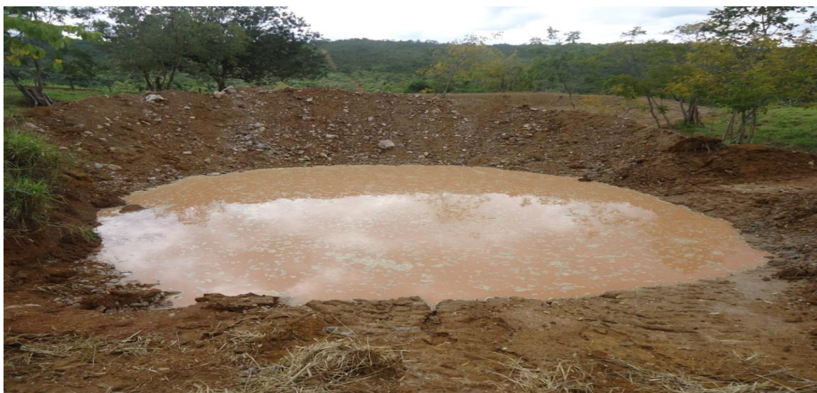
Figura 7 –Bacia de Contenção construída na comunidade de Córrego dos Gomes - Turmalina
