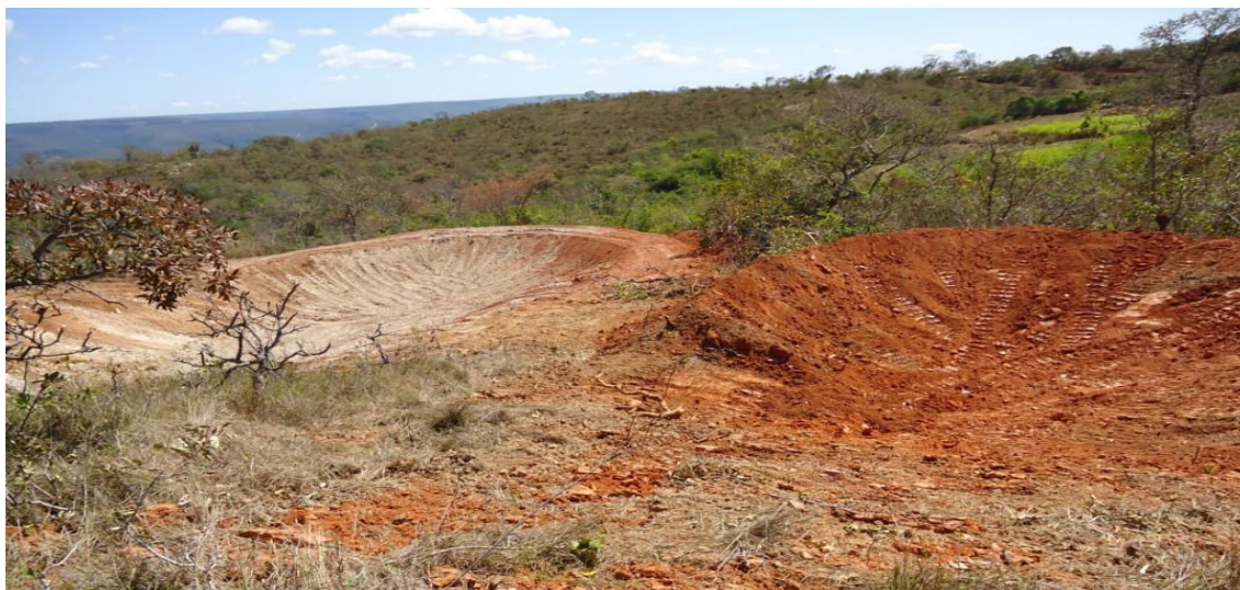
Figura 9 – Barraginha e bacia de contenção construída na comunidade de Tolda
