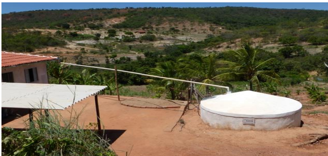
Figura 4 – Cisterna de Placa
