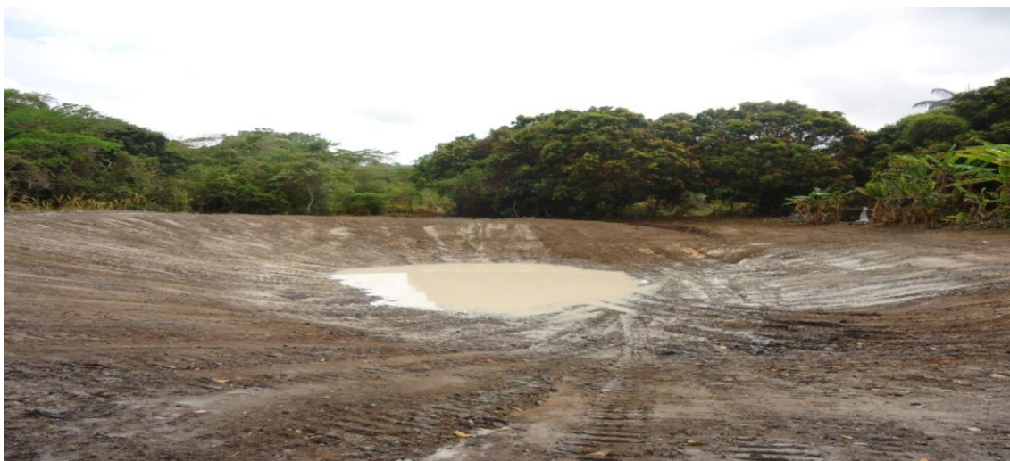
Figura 8 –Barraginha construída na comunidade de Alto Lourenço – Turmalina
