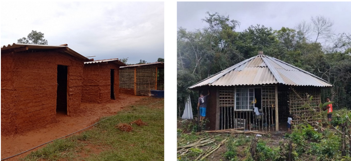
Figura 43: Esquerda: Construção da escola na Aldeia Arapowã Kakyá em pau-a-pique e cobertura em telha de fibrocimento. Fonte: Acervo pessoal. Janeiro de 2023. Direita: Habitação em construção na Aldeia Katurãma mesclando materiais locais e industrializados. Fonte: Publicado no Instagram @curumimmc. Junho de 2023.
