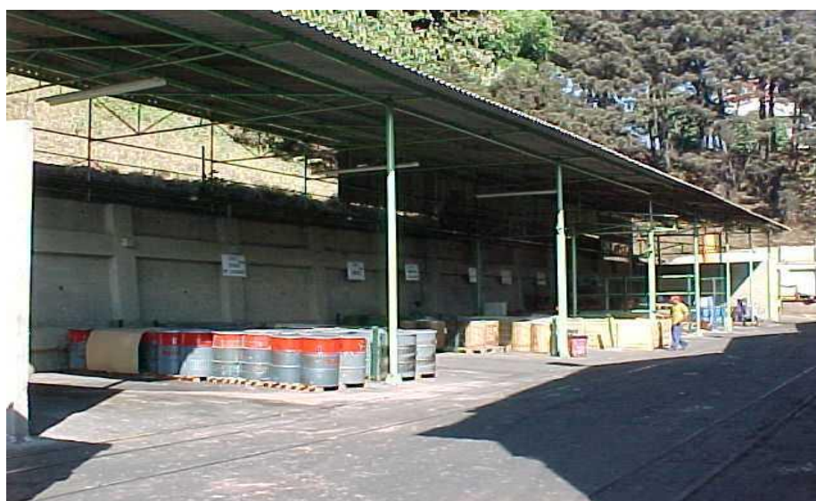
Figura 41 – Central de Resíduos Sólidos (pátio interno) Fonte: Belgo Bekaert, 2007
