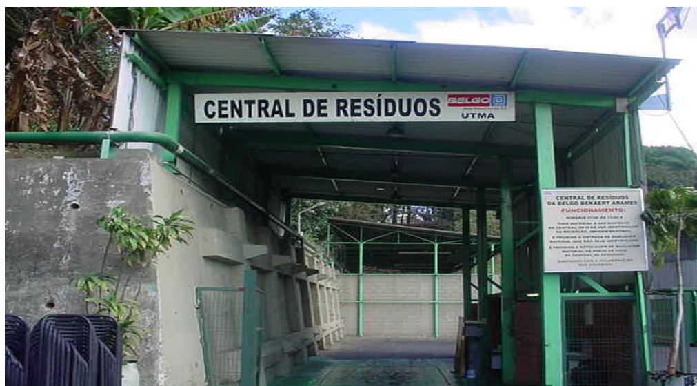
Figura 40 – Central de Resíduos Sólidos (entrada) Fonte: Belgo Bekaert, 2007
