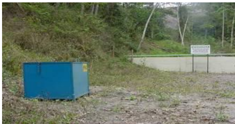
Figura 16 - Poço tubular - monitoramento de águas subterrâneas Fonte: ArcelorMittal Monlevade, 2007
