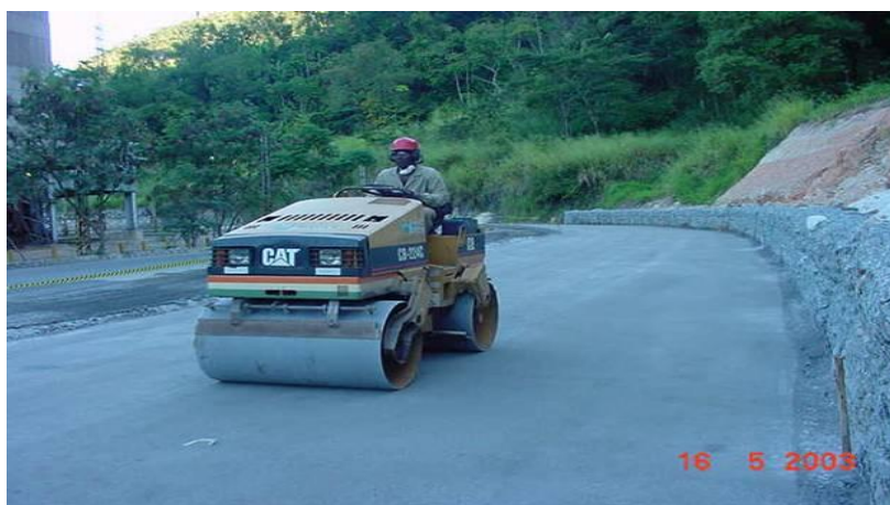
Figura 19 - Pavimentação de área e vias internas da ArcelorMittal Monlevade Fonte: ArcelorMittal Monlevade, 2007
