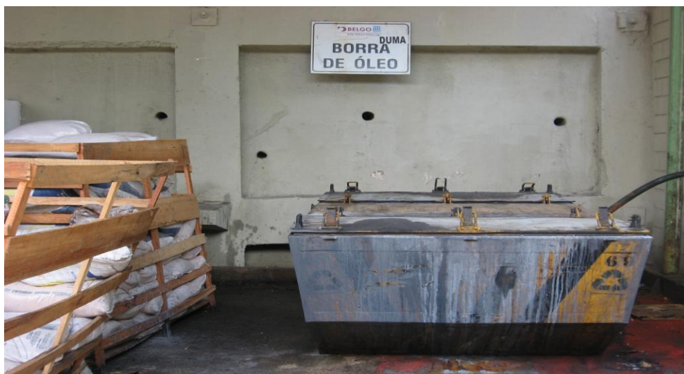
Figura 50 - Box para armazenamento de borra de óleo Fonte: Belgo Bekaert, 2007
