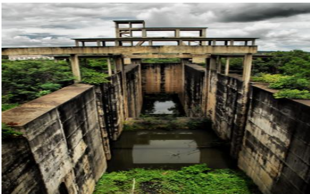
Figura 12- Obra paralisada da eclusa na barragem de Boa Esperança no rio Parnaíba. Fonte: Dias, 2012.
