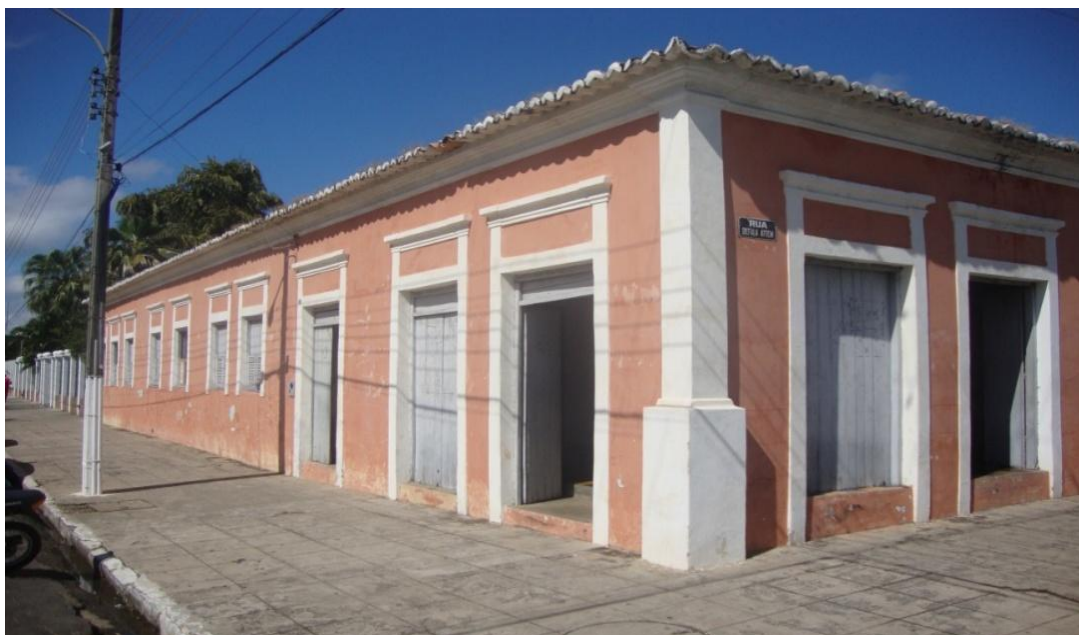
Figura 25 - Fachada da residência e escritório da família Castro, construída em 1905. Fonte: Autor, 2013.
