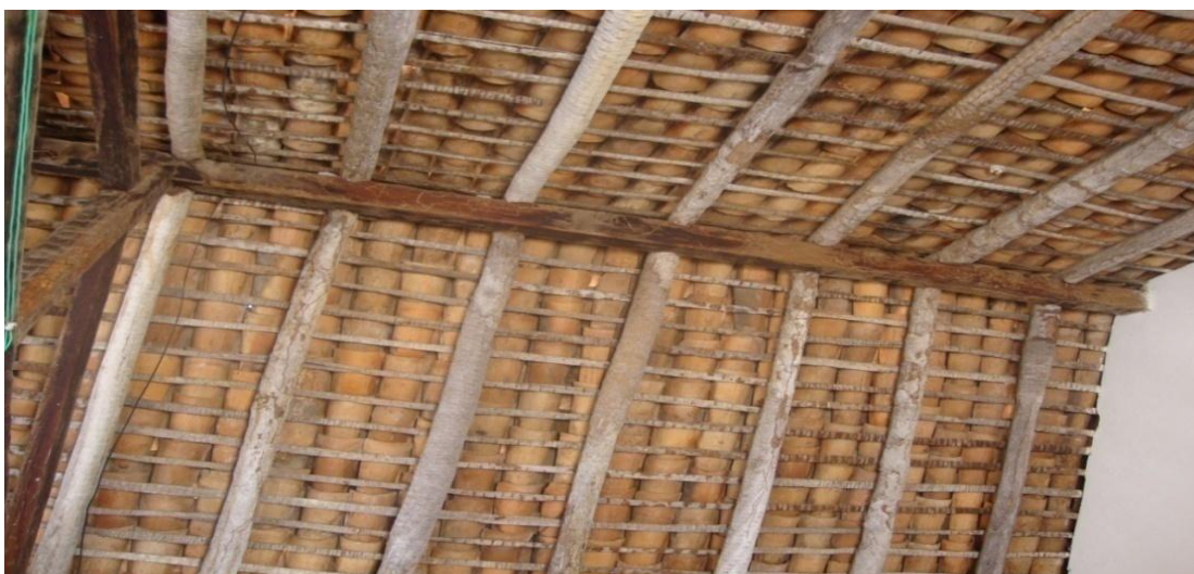
Figura 26 - Interior da residência, com teto sustentado com caibros e ripas de carnaúba. Fonte: Autor, 2013.
