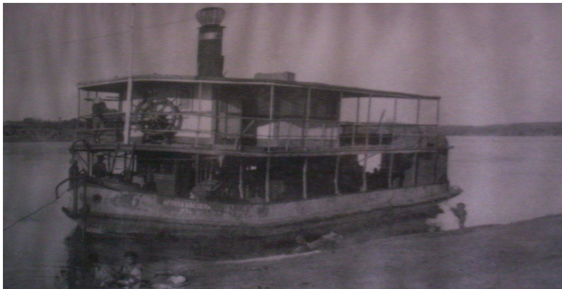
Figura 44 - Vapor Afonso Nogueira construído em Floriano na década de 1930. Fonte: Marcelo Guimarães, 1997.
