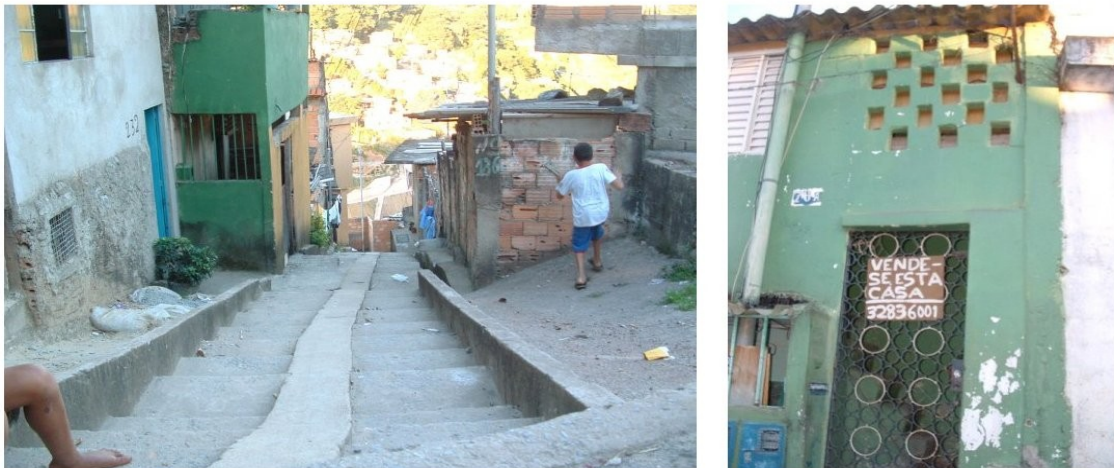
Figura 2 - Construções da Vila Cafezal
