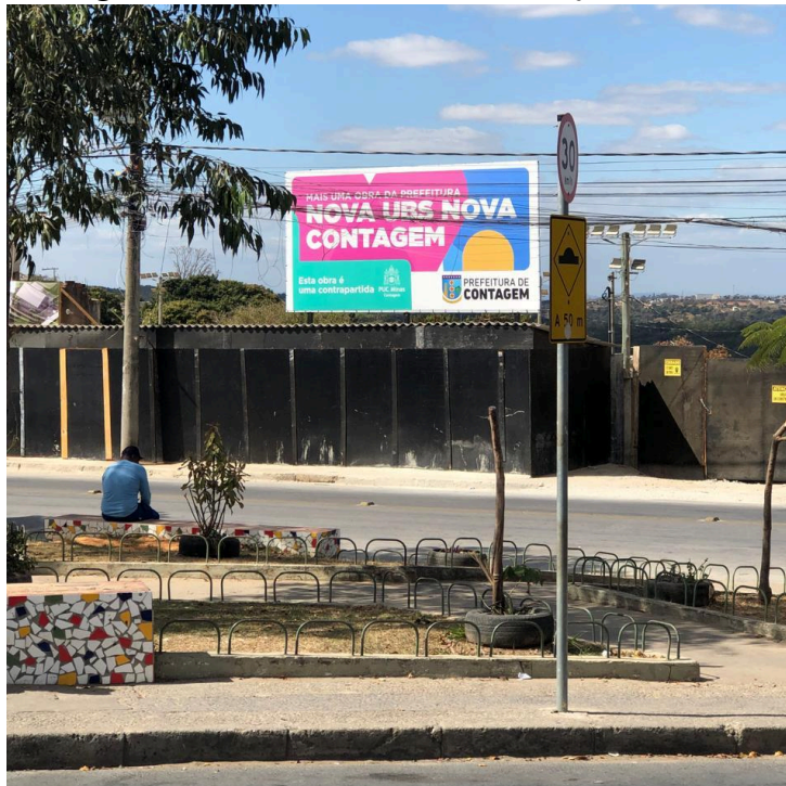
Figura 12 - Foto da obra da construção da UBS
